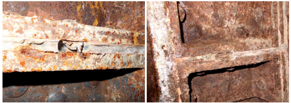
Abb. 4a, b: Schadensbild an Bleifugen und Stahl-tübblingen (Foto: HC Hagemann/Ed. Züblin)
