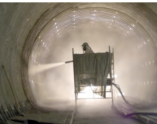
Abb. 9: Ausführung der Spritzbetonarbeiten (Foto: HC Hagemann/Ed. Züblin)
