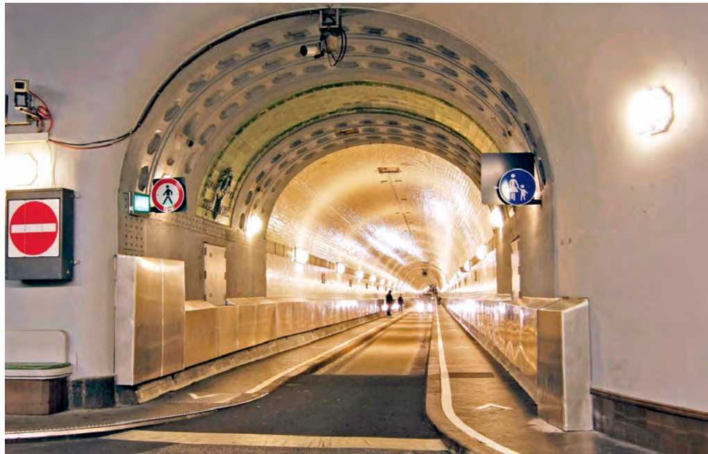
Abb. 1: Blick in die noch nicht sanierte Tunnelröhre (Foto: HC Hagemann/Ed. Züblin)
