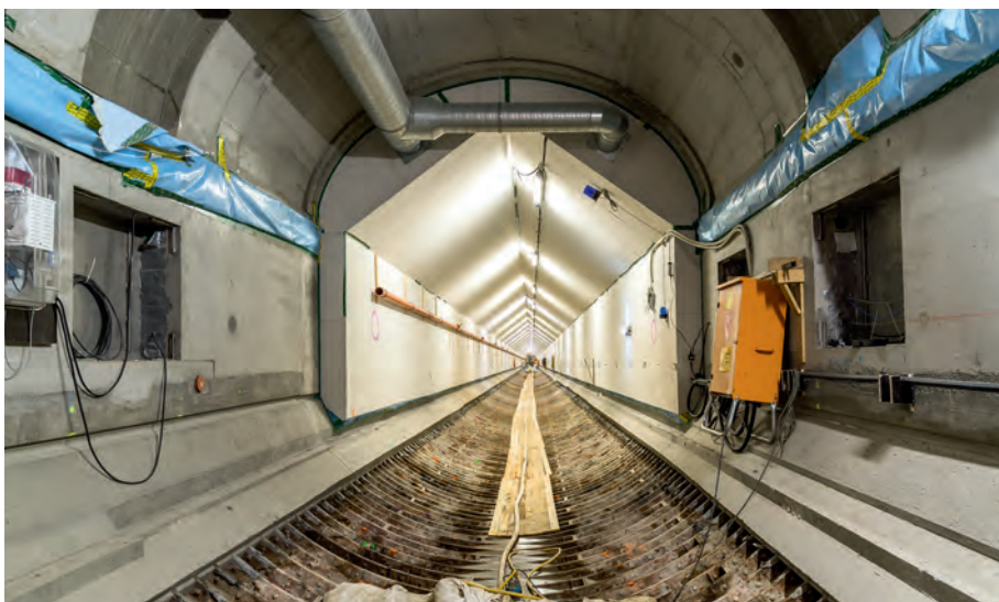
Abb. 12: Schutzeinhausung für die Arbeiten am Fahrblock (Foto: HC Hagemann/Ed. Züblin)
