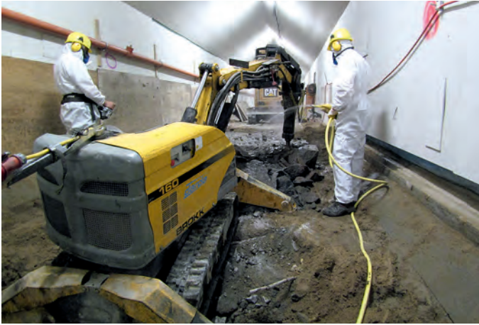
Abb. 13: Rückbau des Fahrbahnblocks (Foto: HC Hagemann/Ed. Züblin)
