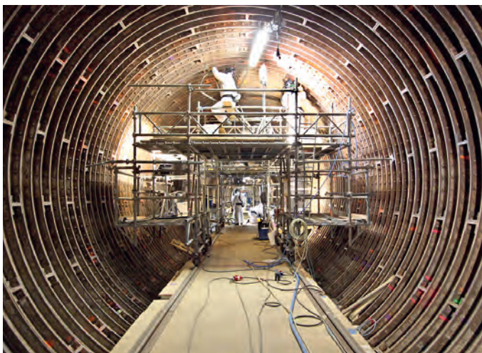
Abb. 5: Nach Abschluss des Abbruchs freigelegte Stahl-tübblinge (Foto: Atlas Copco Tools)
