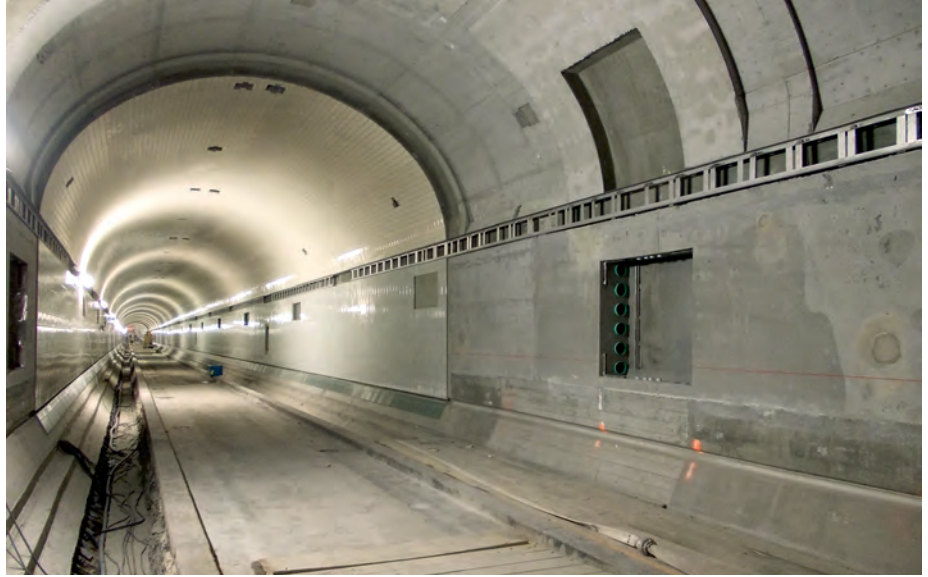
Abb. 11: Neu verflieste Oströhre vor Beginn der Arbeiten am Fahrblock (Foto: HC Hagemann/Ed. Züblin)
