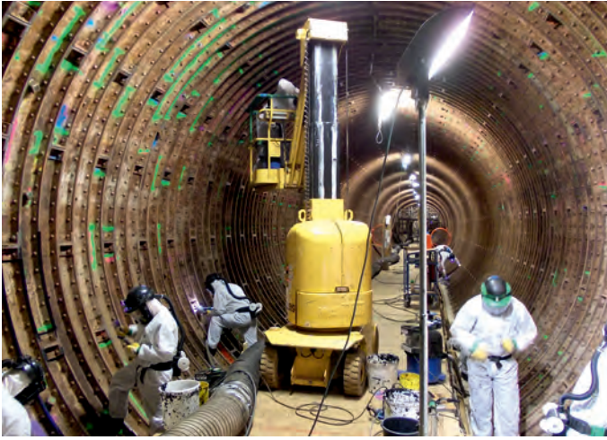
Abb. 7: Sanierungsarbeiten an den Tübbingten unter Vollschutz (Foto: HC Hagemann/Ed. Züblin)
