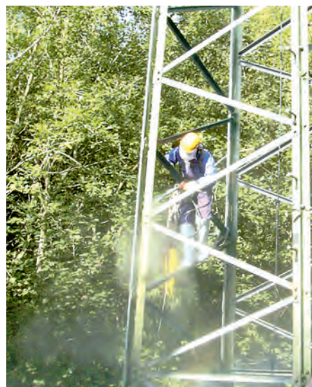
Abb. 2: Reinigungsarbeiten an einem Stahlgittermast mit Flüssigkeitsstrahler (Foto: Waldinger)
