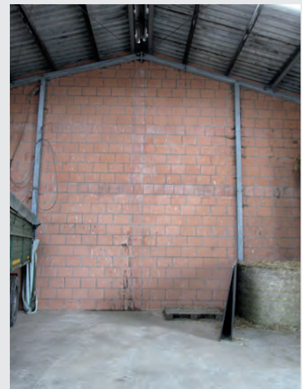
Abb. 2: Die Absturzhöhe betrug ca. 5,50 m (Foto: BG BAU)
