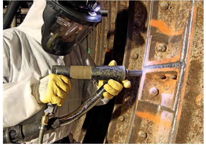
Abb. 8: Einstemmen neuer Bleidichtungen mit Druckluftgeräten und Vollschutz-PSA (Foto: Atlas Copco Tools)
