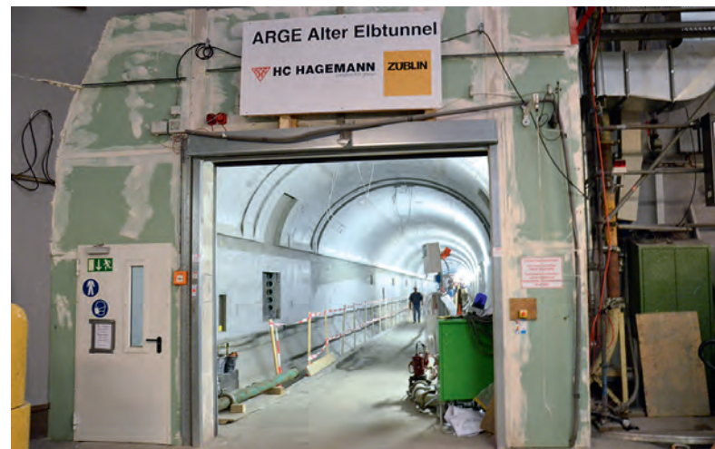
Abb. 6: Toranlage zwischen Portal und Tunnelröhre (Foto: HC Hagemann/Ed. Züblin)
