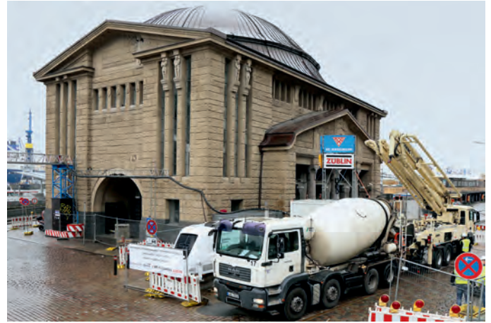
Abb. 14: Schwerbetonanlieferung vor dem historischen Nordportal auf St. Pauli (Foto: HC Hagemann/Ed. Züblin)
