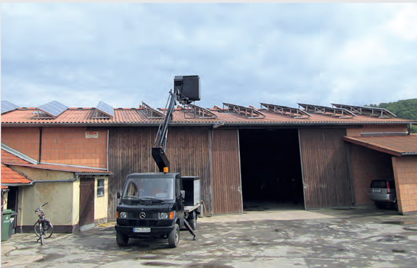
Abb. 1: Die rechten drei PV-Reihen waren bereits gereinigt, bei der vierten Reihe stürzte Z. durch die Lichtplatte (Foto: BG BAU)
