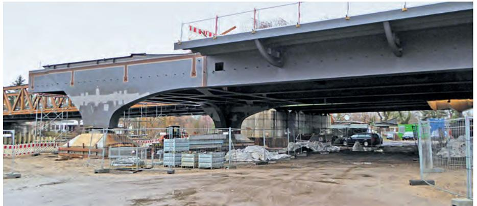
Abb. 20: Bogenmontage mit Hilfe aufwändiger Traggerüste
