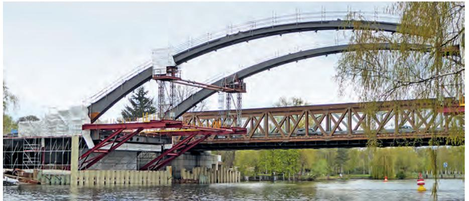
Abb. 21: Einhub des Trägerrostes mittels Litzenheber
