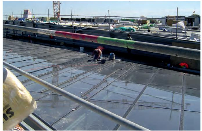
Abb. 5: Die Glasflächen des Daches sollten nicht betreten werden. Da die Arbeiten jedoch dort durchgeführt werden mussten, wo sie anfielen, mussten ersatzweise Maßnahmen abgestimmt werden (Fotos: Prof. Dr.-Ing. Marco Einhaus)
