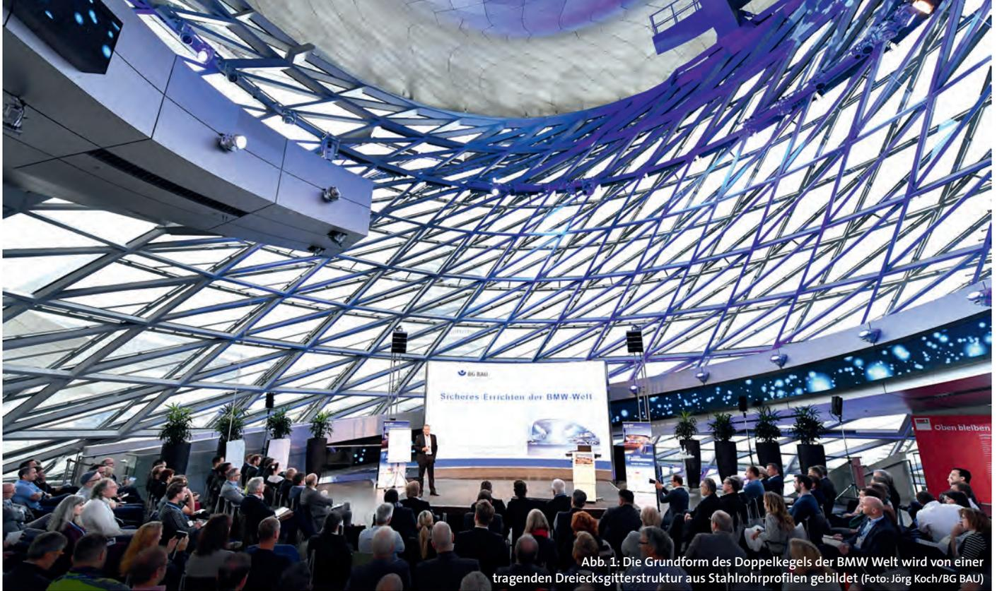
Abb. 1: Die Grundform des Doppelkegels der BMW Welt wird von einer tragenden Dreiecksgitterstruktur aus Stahlrohrprofilen gebildet (Foto: Jörg Koch/BG BAU)
