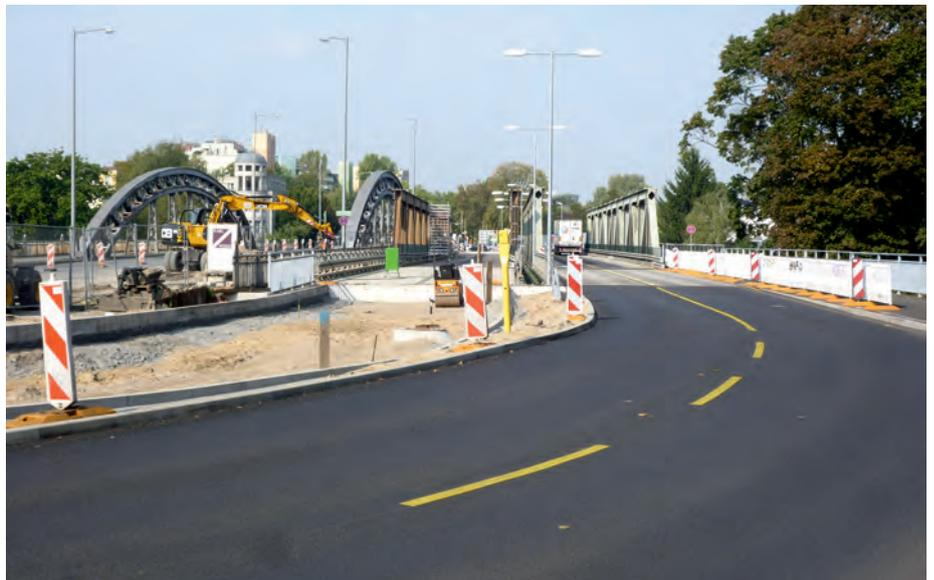
Abb. 14: Stromfeld und westliche Vorlandbrücke der Behelfsumfahrung
