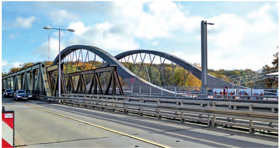
Abb. 22: Ersatzneubau und Systembrücken der Behelfsumfahrung
