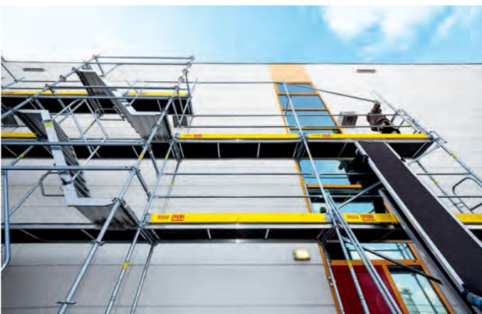
Abb. 17: Gerüst mit systembedingter, integrierter Absturzsicherung: Die Aufbauabfolgenfolge lässt keine Arbeiten ohne Seitenschutz zu (Foto: PERI)
