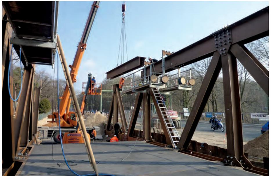
Abb. 15: Montage der Systemfachwerkbrücke SS 80
