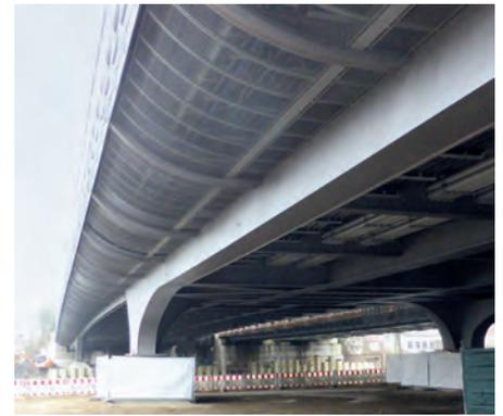
Abb. 12: Vorlandbrücke mit unterseitiger Verkleidung der Gehwegkonsolen
