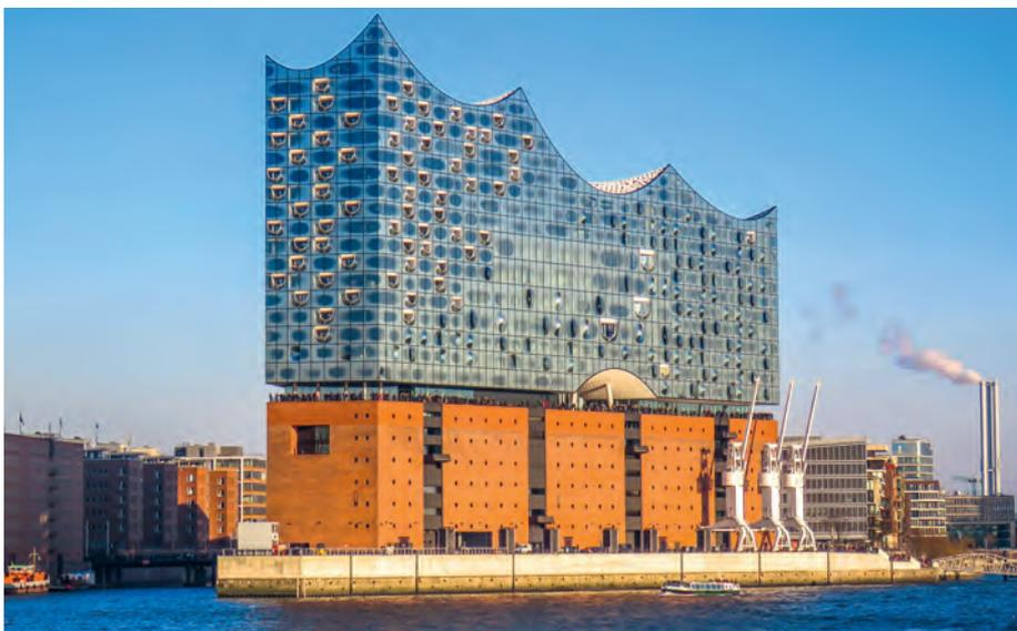
Abb. 13: Die bis zu 5 m großen Glasscheiben sind teilweise konkav und konvex gewölbt, jedes Element ist ein Unikat. Diese Wölbung der Glasflächen (nach innen und außen um je 35 cm) erschwert die Reinigung (Foto: © Raimond Spekking / CC BY-SA 4.0 (via Wikimedia Commons) ([https://commons.wikimedia.org/wiki/File:Elbphilharmonie,\\_Februar\\_2015-4971.jpg](https://commons.wikimedia.org/wiki/File:Elbphilharmonie,_Februar_2015-4971.jpg)), <https://creativecommons.org/licenses/by-sa/4.0/legalcode>)
