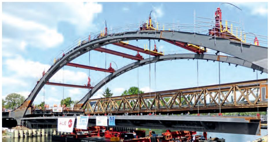
sem Rückbau und dem Abtransport auf Lkw konnten auch die SB 30-Brücken der Vorlandbereiche mittels Kran demontiert werden. Die abschließenden Arbeiten des Abbruchs der Behelfsunterbauten und des Rückbaus der Dammverbreiterung erfolgen derzeit noch.
