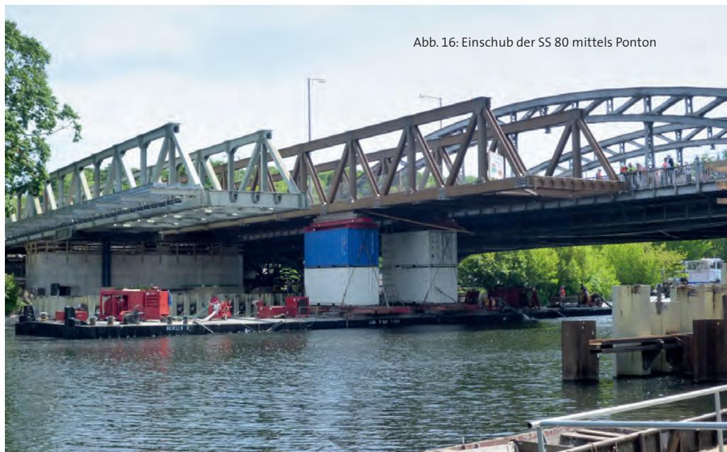
Abb. 16: Einschub der SS 80 mittels Ponton
