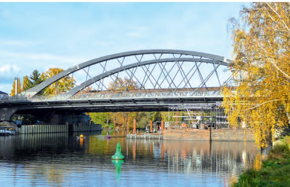
wobei die Querschnittshöhe zum Lagerpunkt hin kontinuierlich zunimmt und in kräftig gestaltete Vouten übergeht. Die Ausbildung der Hänger erfolgt mit Flachstahlhängern im Netzwerksystem mit radialer Anordnung. Vor dem Bogenanschluss kreuzen sich die Hänger unter einem Winkel von  $60^\circ$ .
