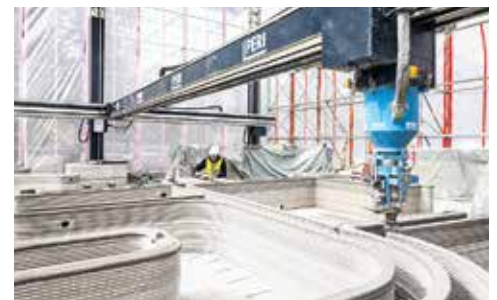
... und der 3D-Betondruckvorgang.
