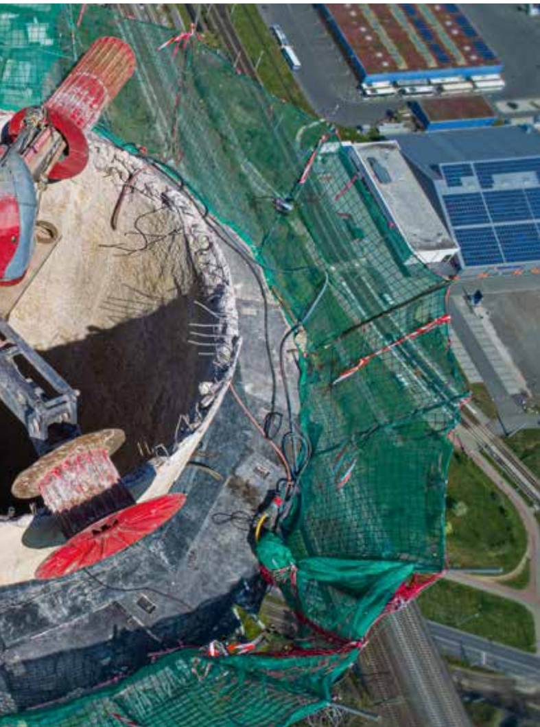
Abb. 1: Schornstein- abbruch mittels Drivebreaker im Schutze eines Schornstein- konsolgerüsts
