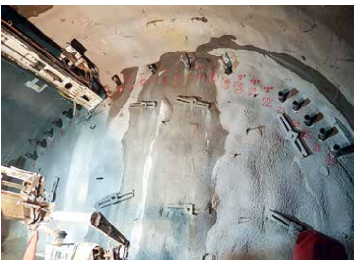
Herstellung des Rohrschirms
