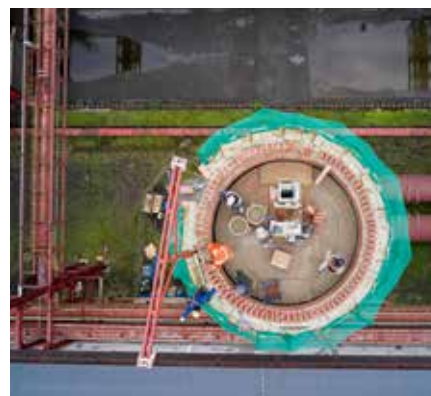
Die radiale Aufzugs- und Arbeitsplattform hat das Team von Mende selbst entwickelt.
