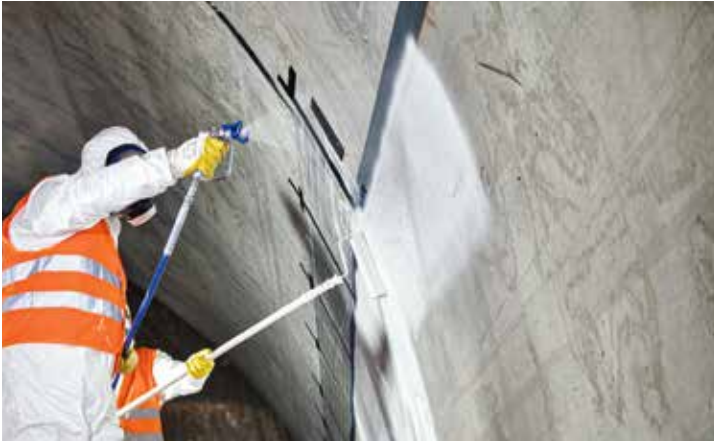
Das OS-2-Beschichtungssystem wird in nur einem Arbeitsgang appliziert. Dazu wird es airless gespritzt und sofort nachgerollt.
