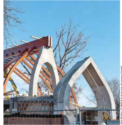
Schalung für das neue Gotteshaus mit seiner aufwendigen monolithischen Tragkonstruktion aus Beton.
