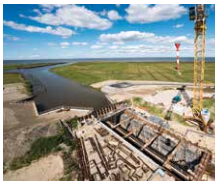
Die Hadelner Kanalschleuse ist gegenwärtig die größte Küstenschutzbaumaßnahme des Bundeslands Niedersachsen.
