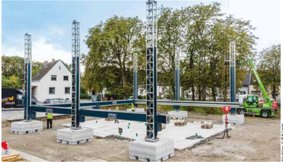
Aufbau des BOD2-Betondruckers in Beckum ...
