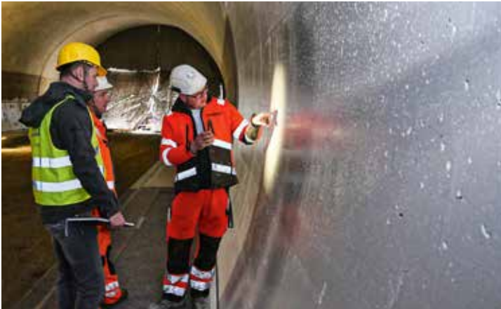
Überprüfung der flächendeckenden Beschichtung der Tunnelwände
