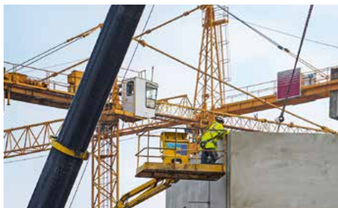
Gesichertes Arbeiten mit PSaG in der Hubarbeitsbühne
