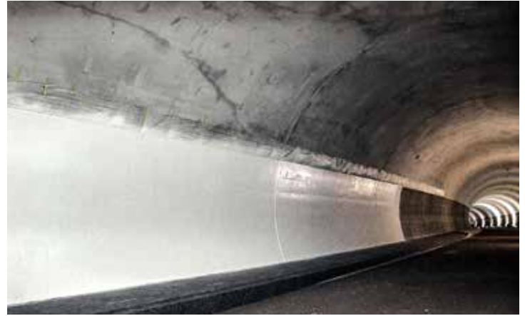
Die Tunnelbeschichtung weist einen hohen Reflexionswert auf und lässt sich mit Wasser umweltfreundlich reinigen.
