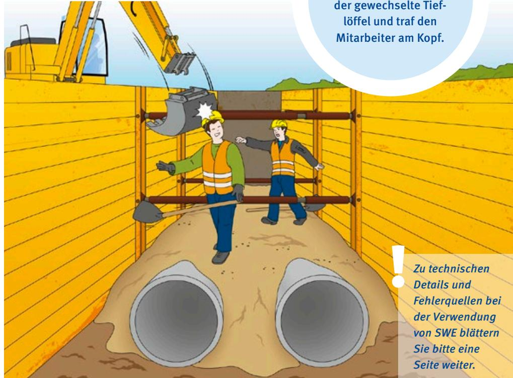
Als der Ausleger des Baggers herumschwenkte, löste sich der gewechselte Tieflöffel und traf den Mitarbeiter am Kopf.
