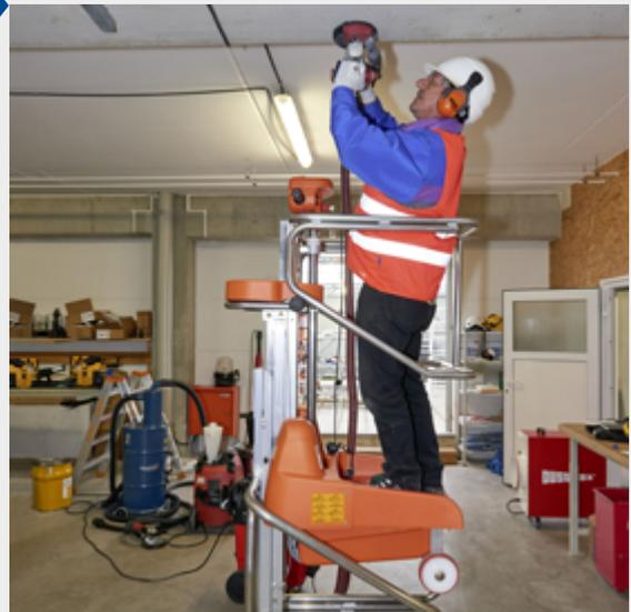
Kleinsthubarbeitsbühnen und Lifte stellen eine effiziente und sichere Alternative zu Leitern mit Standhöhen von bis zu circa fünf Meter dar. Sie bieten mit ihrem geringen Eigengewicht, ihrem in manchen Fällen energieunabhängigen Betrieb und einer stufenlos verstellbaren Höheneinstellung zusätzliche Vorteile.
