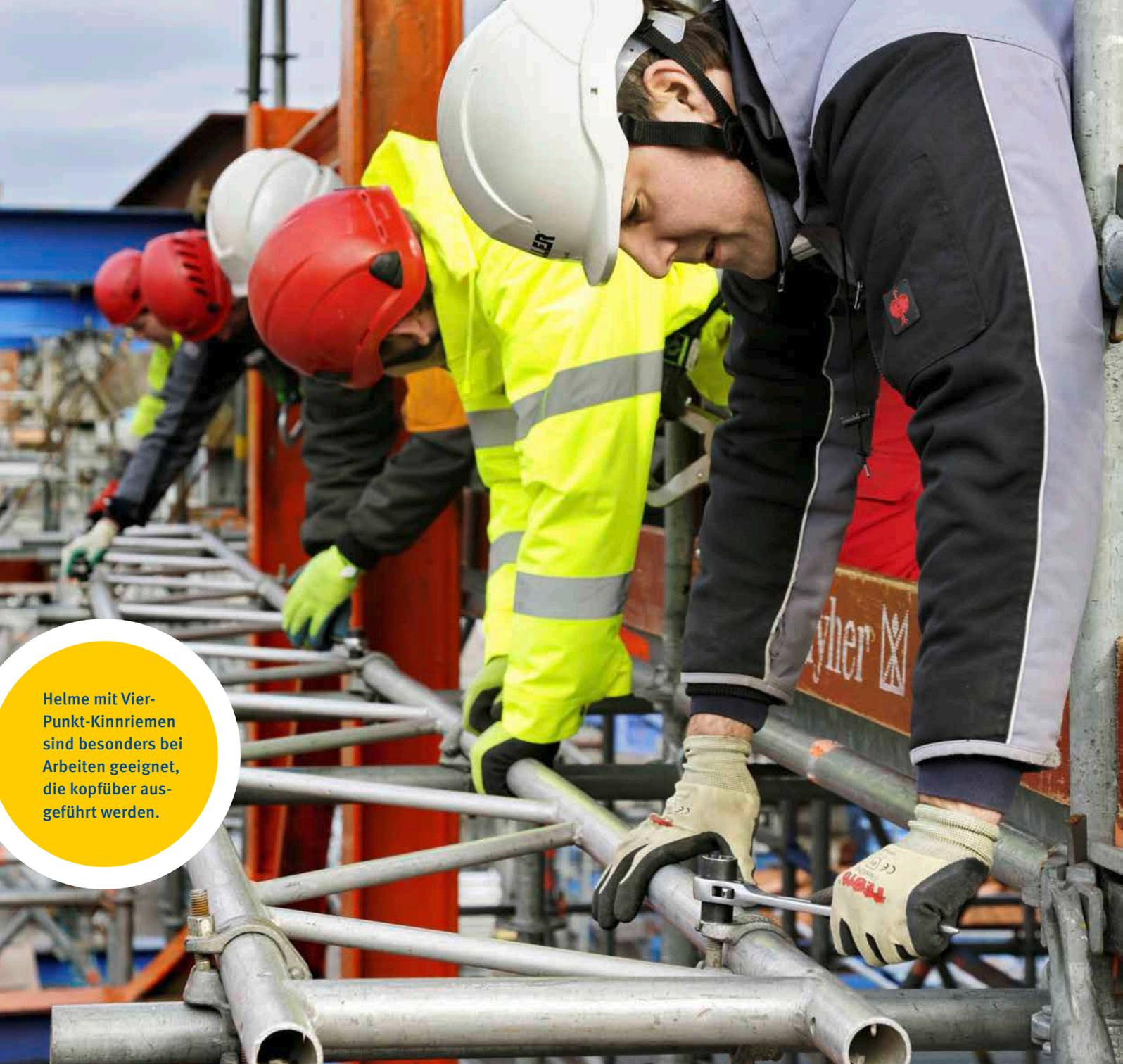
Helme mit Vier-Punkt-Kinnriemen sind besonders bei Arbeiten geeignet, die kopfüber ausgeführt werden.
