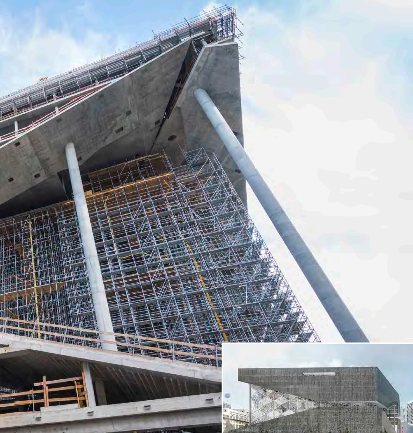
**G**enau dort, wo vor Jahrzehnten der Todesstreifen verlief, trägt eine 1,20 Meter starke Stahlbetonplatte die Last des 13-geschossigen zukünftigen Verlagsgebäudes. Seine trapezförmige Grundfläche wird diagonal von einem 45 Meter hohen Atrium durchzogen, das auf der Nordost- und Südwestecke jeweils in einer frei stehenden Glasfassade mündet.
