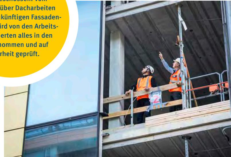
für das Gerüst, die Metallbauer erläutern es ihnen. Sie nicken, alles in Ordnung. Der Stahlträger ist ein Element der über 1.000 Tonnen wiegenden Temporärkonstruktion, die bis vor kurzem das Gewicht der fünf Stockwerke über dem Atrium hielt. Nach der erfolgreichen Lastumlagerung auf ein dauerhaftes Transfertragwerk wird sie nun demontiert.
