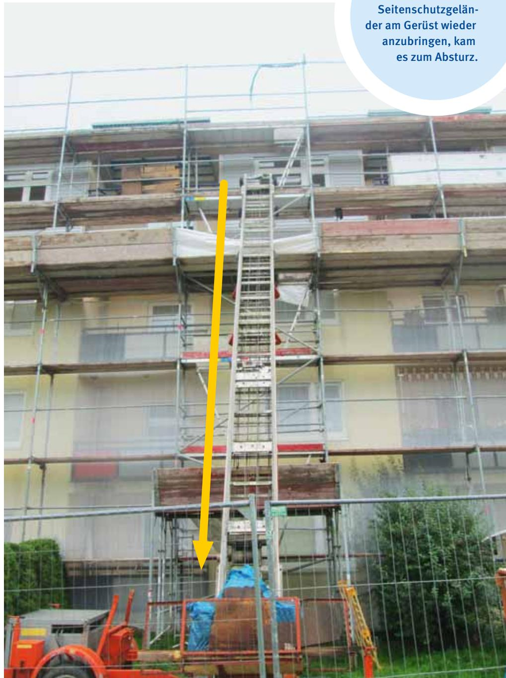
Beim Versuch, das abmontierte Seitenschutzgelenk am Gerüst wieder anzubringen, kam es zum Absturz.
