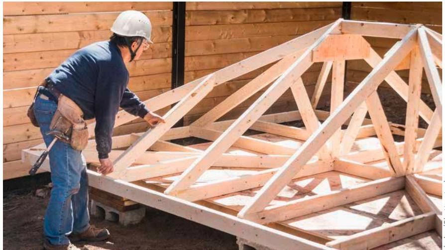
Wenn Holzdachstühle auf ebener Fläche montiert und später per Kran aufgesetzt werden, ergeben sich ein deutlich höheres Arbeitsschutzniveau und wirtschaftliche Vorteile.
