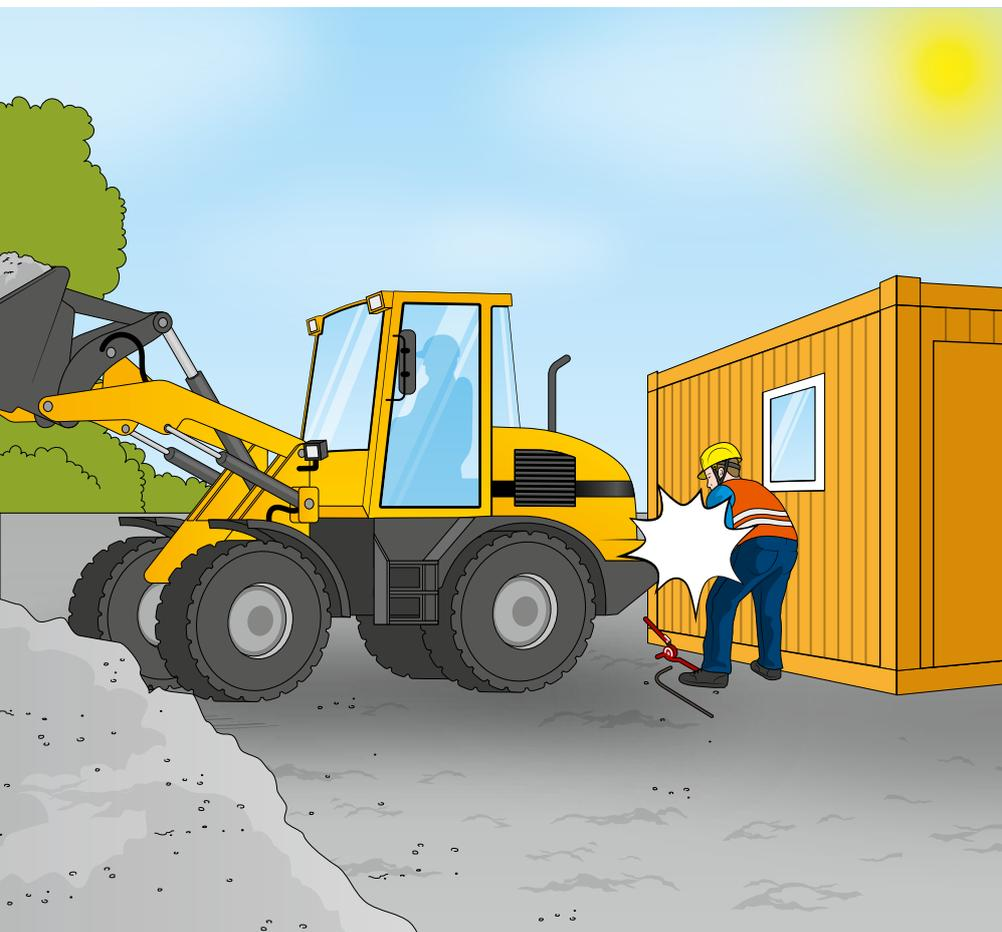
**B**ei Tiefbauarbeiten auf einem Privatgelände herrschte reger Betrieb. Für ein Autohaus sollten eine Zufahrt und Parkplätze geschaffen werden. Ein Baumaschinenführer verwendete einen Radlader, um Mineralbeton von der Lagerstätte dorthin zu fahren und zu verteilen, wo er eingebaut werden sollte. Dazu musste er zwischen dem Mineralbeton und einem sich in der Nähe befindenden Baucontainer zurücksetzen. Dort hatte sein Kollege gerade Material aus dem Baucontainer geholt und bearbeitete es in
