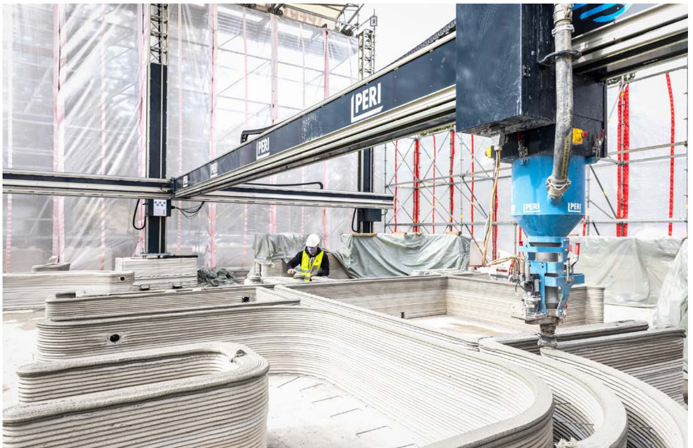
Runde Ecken und ungewöhnliche Formen: Das Unternehmen Peri stellt ein Wohnhaus mit dem 3-D-Betondruckverfahren her.
