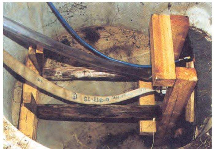
Abb. 6: Zur Aufnahme der Kräfte aufgrund des Leitungsdrucks zimmermannsmäßig hergestellte Sicherung (Foto: BG BAU)
