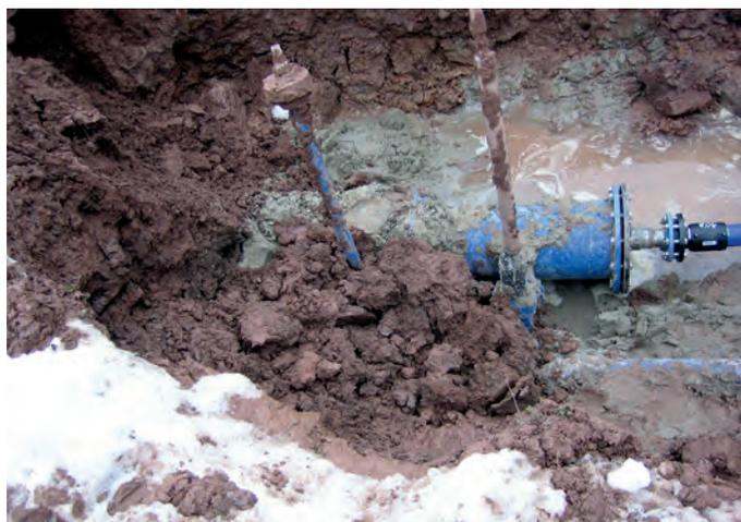
bau zur Sicherung. Der Böschungswinkel hängt von der Bodenart ab. Der Verbau muss bei Tiefen bis 2,00 m 5 cm überstehen, bei mehr als 2,00 m sind es 10 cm. Bei mindestens steifen bindigen Böden kann der Verbau kurzzeitig bis zu 0,50 m oberhalb der Aushubsohle unter den o.g. besonderen Bedingungen enden (Vereinfachung für die Herstellung der Rohrzone). Inzwischen ist für jeden Einsatzzweck ein geeigneter Verbau zu finden (z.B. für zusätzliche Aufnahme von Verkehrs- oder Bauwerkslasten).
