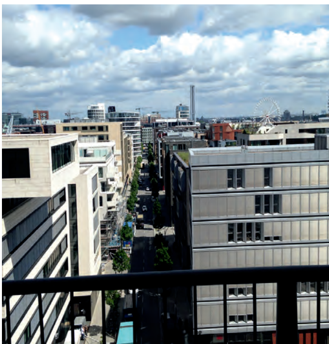
Abb. 1: Flachdächer soweit das Auge reicht (Foto: BG BAU/Heiland)
