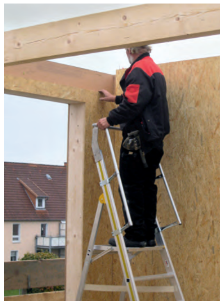
Abb. 9: Montagearbeiten auf einer Fertighausbaustelle
