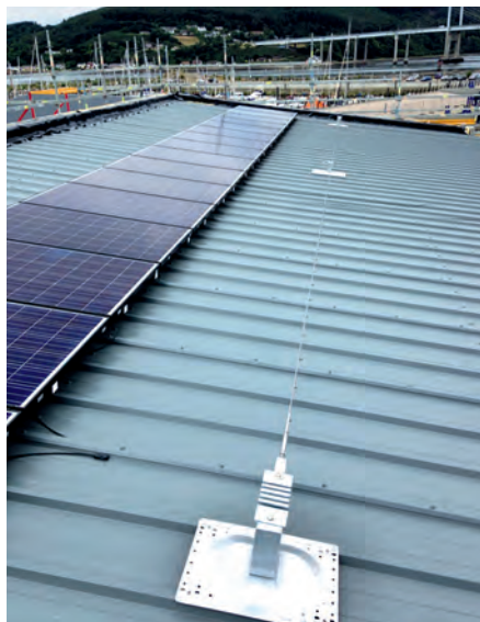
Abb. 14: Ein horizontales Seilsicherungssystem lässt sich auf stark bebauten Dachlandschaften flexibel installieren und ist auf verschiedenen Dachtypen einsetzbar (Foto: Kee Safety)
