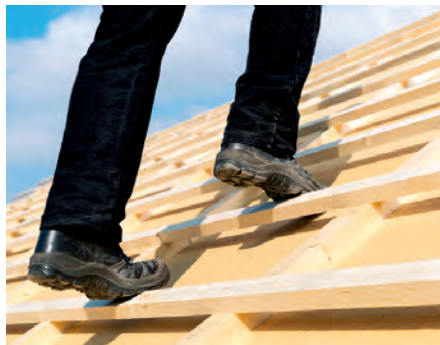
Abb. 3: Die maschinell sortierte Dachlatte garantiert Trittsicherheit
