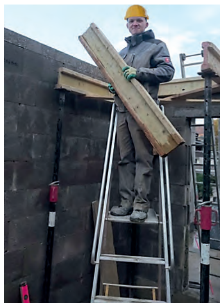
Abb. 6: Aufstellen der Deckenjoche zur Aufnahme von Filigrandeckenelementen
