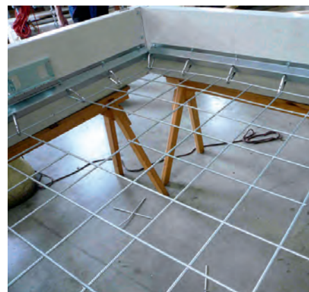
Abb. 7: Nachträglich eingebautes Durchsturzgitter (Foto: BG BAU/Otto)
