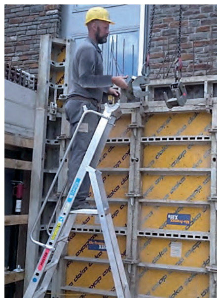
Abb. 7: Lösen von Anschlagmitteln (Fotos 5–7: BG BAU)
