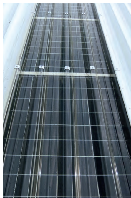
Abb. 7: Nachträglich eingebautes Durchsturzgitter (Foto: BG BAU/Otto)
