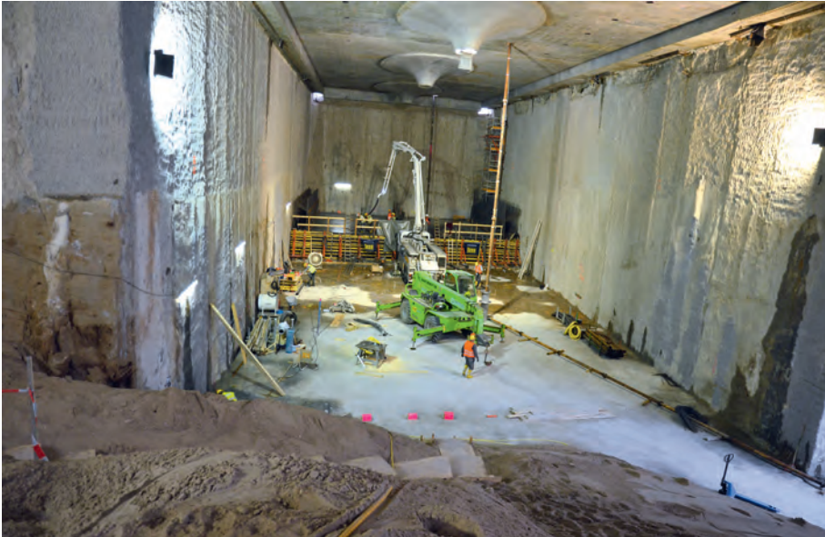
Abb. 10: Betonieren der Bodenplatte ca. 20 m unter Gelände; rechts hinten befindet sich ein Notausstieg (Foto: Maik Kopsch)
