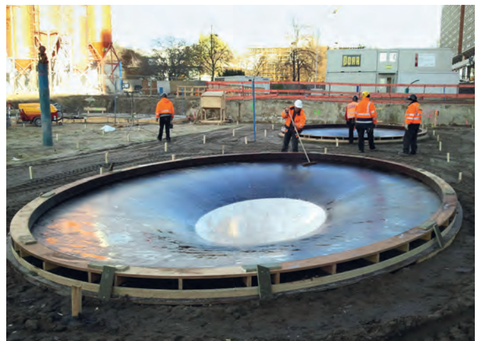
Abb. 6: Schalung Pilzköpfe (Foto: Torsten Schwenke)
