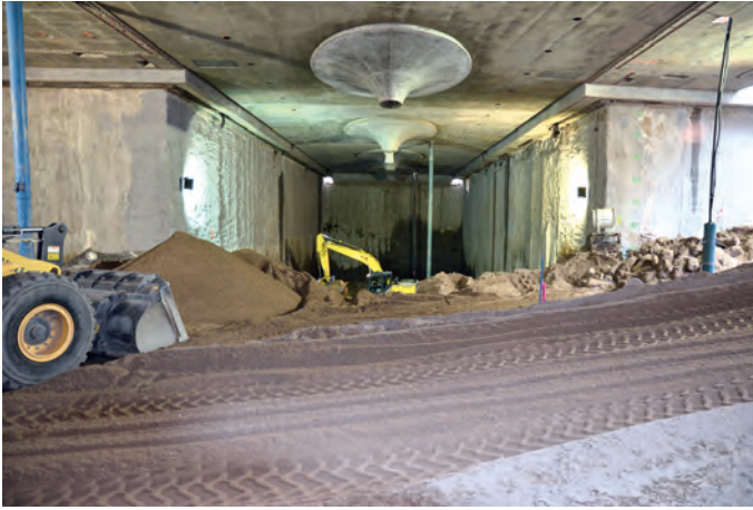
Abb. 5a: Aushub unter dem Deckel (Foto: Maik Kopsch)
