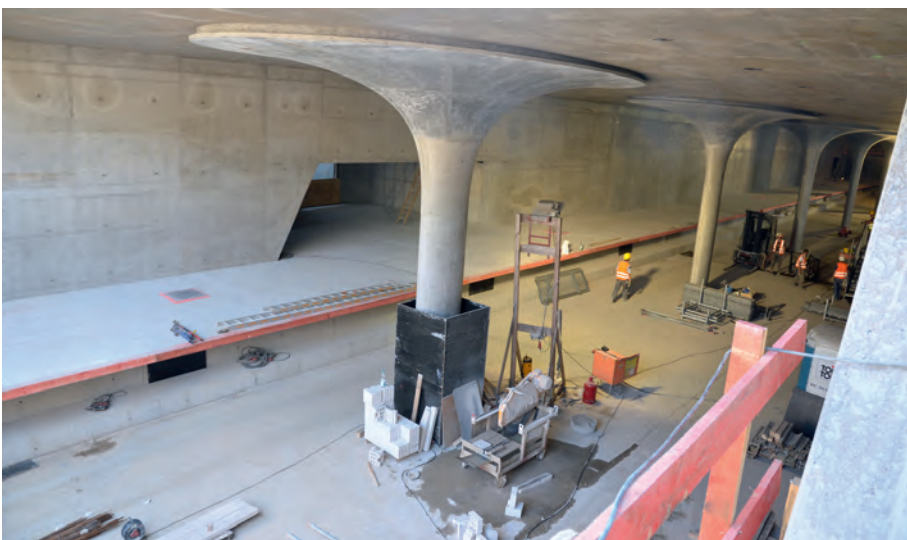
Abb. 12: Fertiger Rohbau (Foto: Maik Kopsch)
