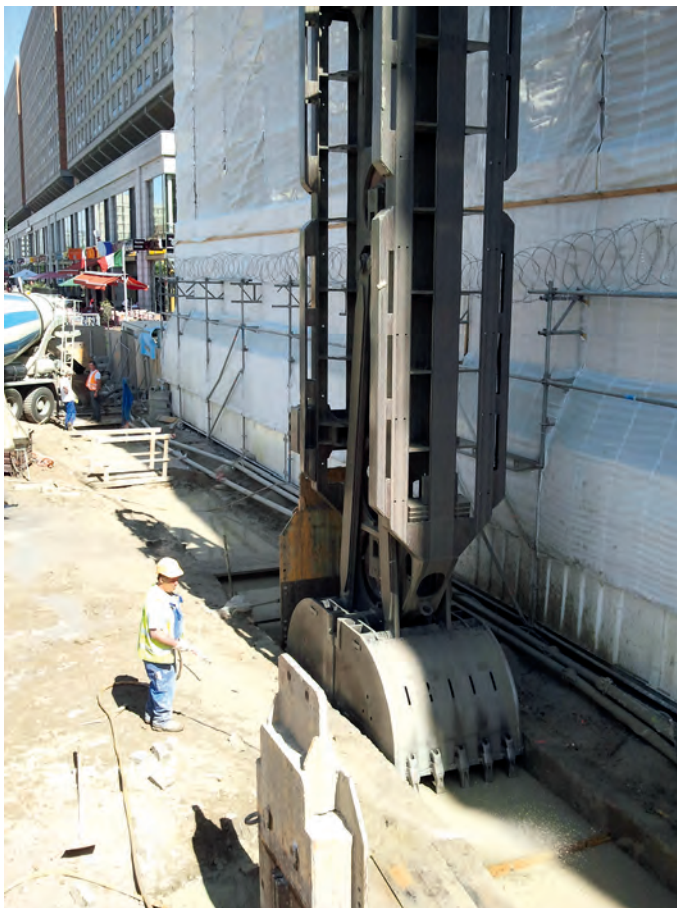
Abb. 3: Schlitzwandarbeiten (Foto: Torsten Schwenke)
