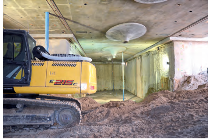
Abb. 5b: Für die Arbeiten im Tunnel kommen Baumaschinen mit Emissionsfilter zum Einsatz (Foto: Maik Kopsch)
