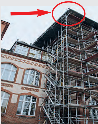
Abb. 1: Vor der Demontage des Wetter- schutzdaches
