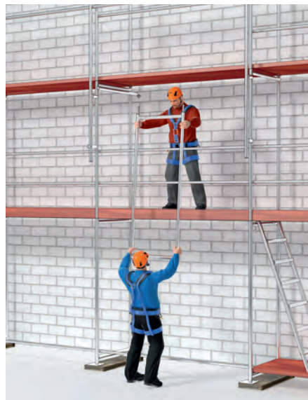
Abb. 2: Kopfschutz beim Gerüstbau (Aufbau, Abbau, Umbau)
