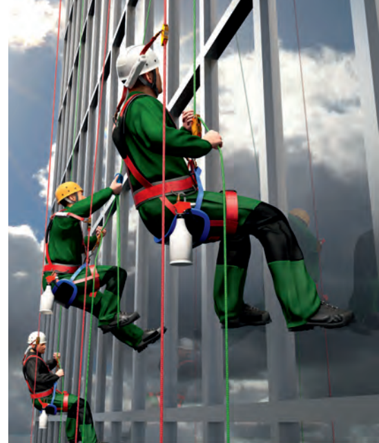
Abb. 1: Kopfschutz bei Fassadenarbeiten
