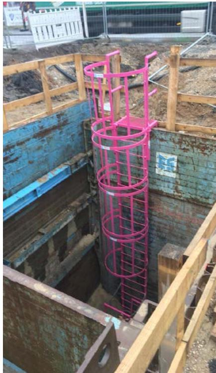
entwickelt. Ähnlich einer Steigleiter besitzt sie Podeste an Ein- und Ausstieg in Form von Gitterrosten und ist auf ganzer Länge bis zur Grubensohle mit einem Rückenschutz versehen. Rutschhemmende Trittplatten und eine Sicherung am Leiterkopf sind weitere Sicherheitskomponenten. Je nach Höhenunterschied lässt sich die Verbauleiter abschnittsweise erweitern. Für Gruben mit Spundwänden wurde eine darauf abgestimmte Variante entwickelt. Mit beiden Leitertypen gelangen Beschäftigte gut gesichert
