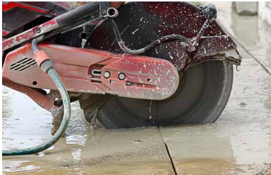
Wasser bindet den beim Betonschneiden entstehenden Staub unmittelbar.
