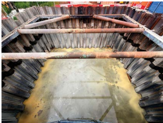
Fertige Unterwasserbetonsohle im Unterhaupt und Lenzen der Baugrube
