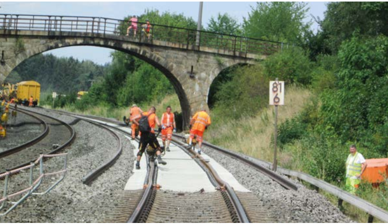
Schraubmaschinen im Gleis ohne FA. Mit Bewegungen und Ausweichen Richtung Nachbargleis ist zu rechnen.
