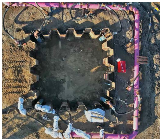
Spundwandkästen sichern den Gefahrenbereich.
