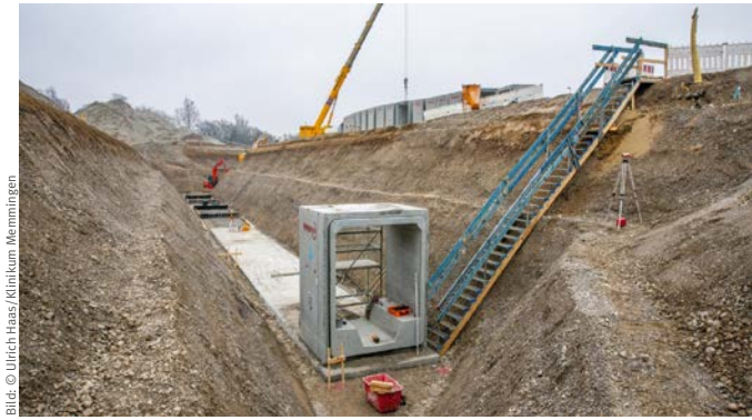
Eines der 170 Profile für den neuen Mischwassersammler, welcher für den Neubau umverlegt wurde.
