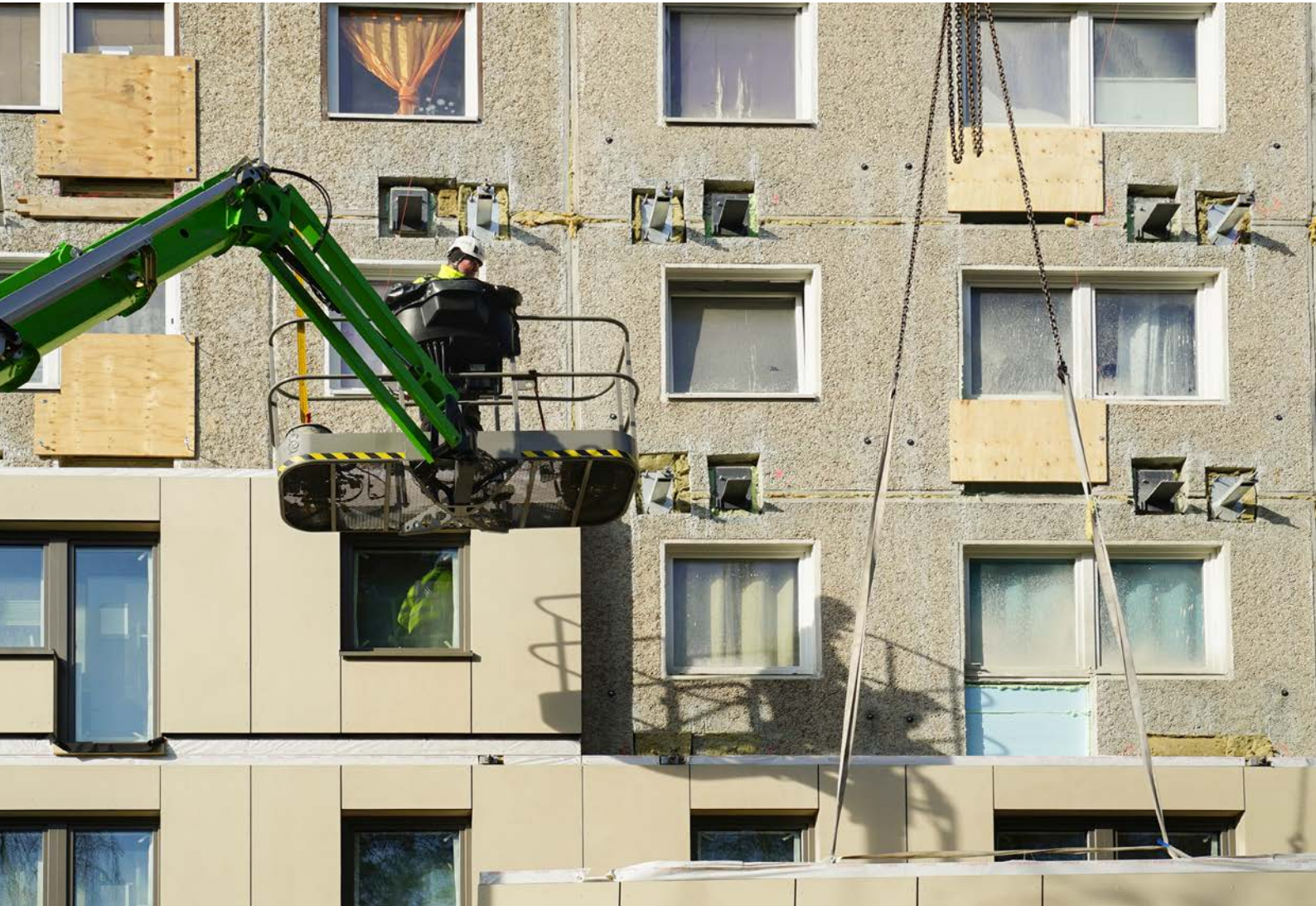
Die ersten Elemente auf der Loggiaseite sind montiert.
