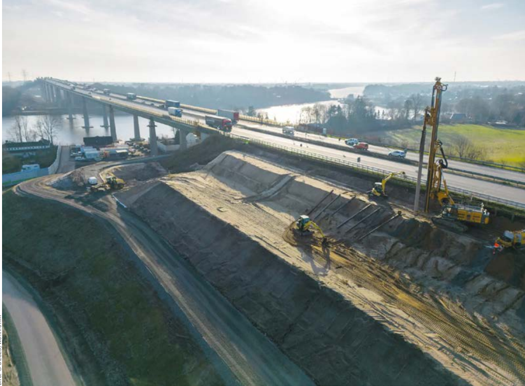
Erdarbeiten zur Verbreiterung des Damms für die spätere Verschubbahn am nördlichen Ende der Brücke
