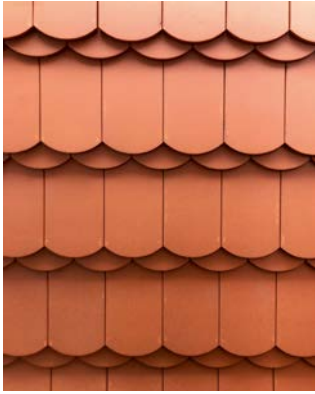
Das Dach ist durch naturrote Biberschwanzziegel gedeckt.
