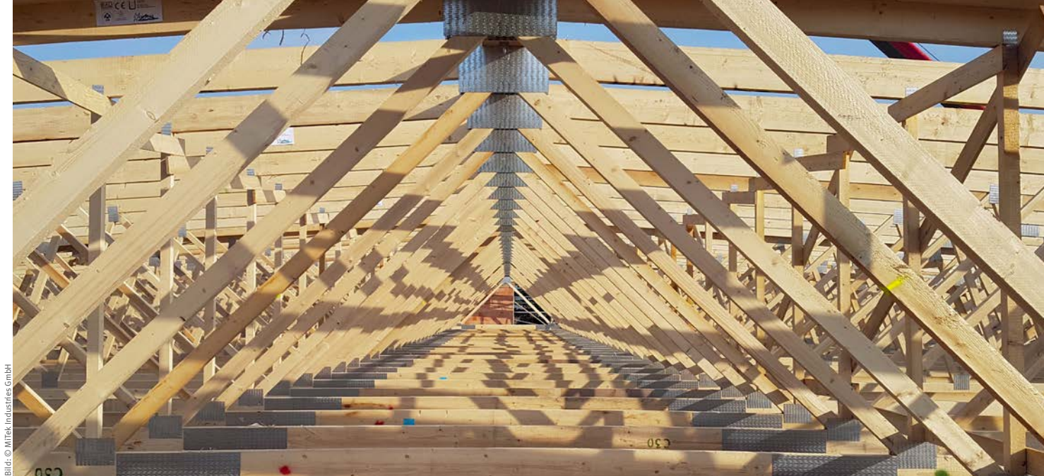
Detailansicht Nagelplattenbinder
