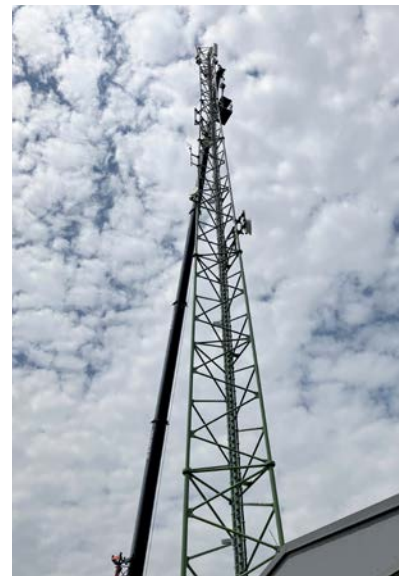
Am 52 m hohen Richtfunkturn des Umspannwerks in Frauenkirchen wurden die SensorBolts erstmalig an repräsentativen Verbindungspunkten verbaut.
