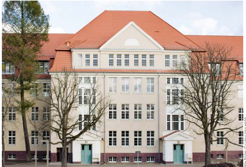
Das Gebäude nach der Sanierung
