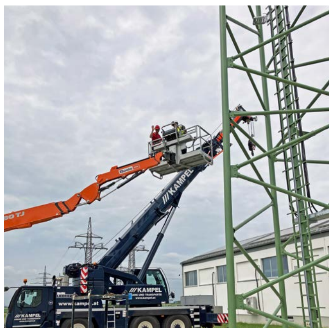
fischer-Experten begleiteten die Monteur der Unger Stahlbau Ges.m.b.H. beim Einbau und bei der Inbetriebnahme des Schraubenüberwachungssystems.
