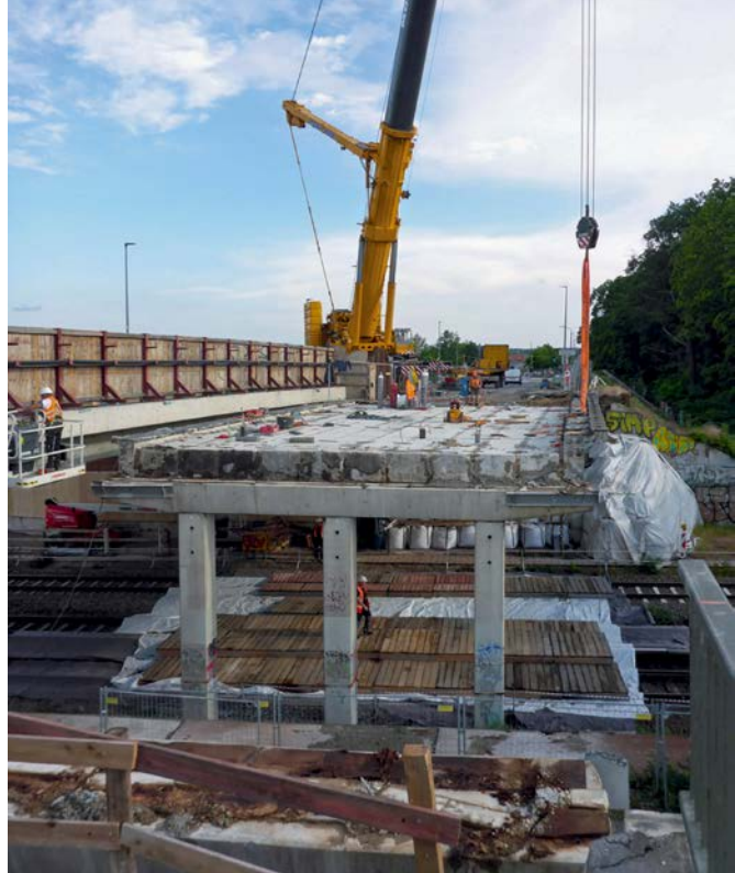
Gleissicherung beim Rückbau des alten Brückenbauwerks
