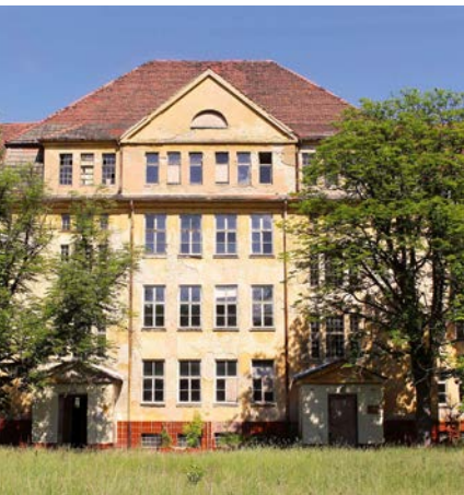
Das Gebäude vor der Sanierung
