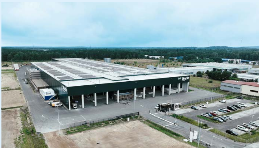
Das neu eröffnete Holzmodulwerk in Eberswalde
