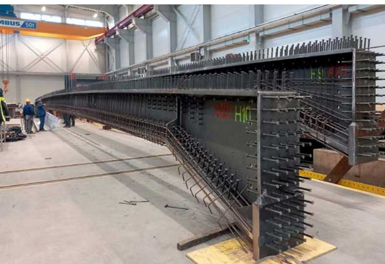
Werkseitige Herstellung der Doppelverbundträger
