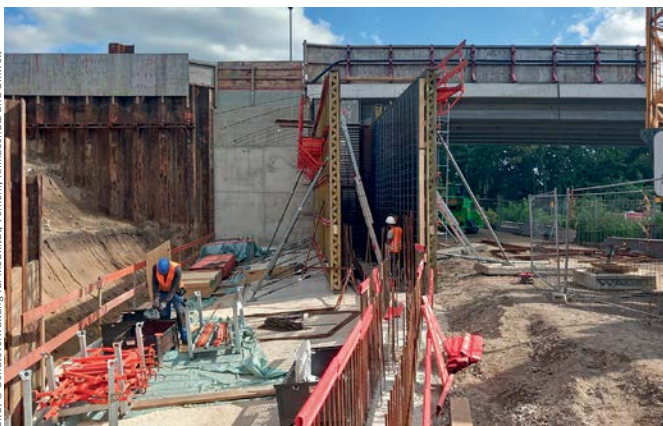
Schalungsarbeiten am Widerlager
