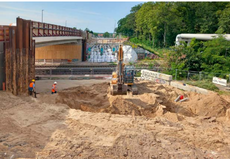
Rückbau der Widerlager direkt neben den Bahngleisen
