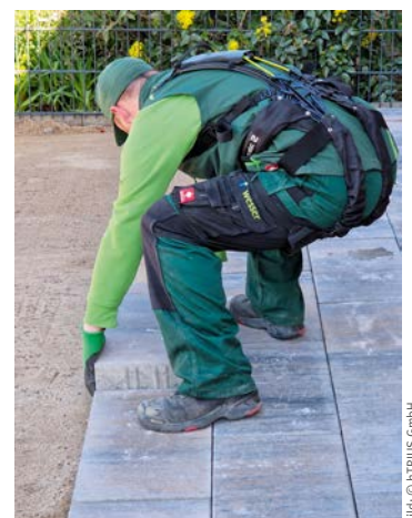
Passives Exoskelett für Arbeiten mit nach vorn geneigtem Oberkörper
