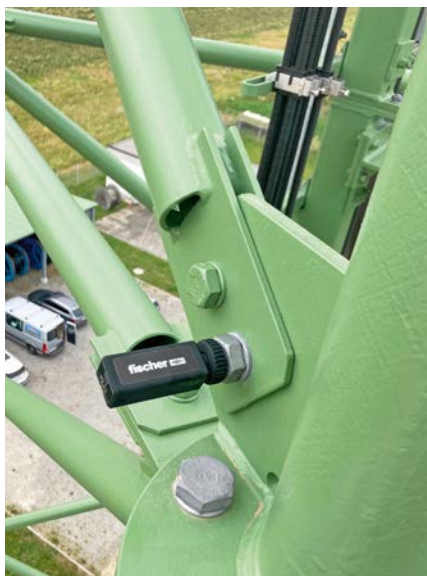
Die SensorBolts können aus der Ferne den Zustand der Befestigungspunkte überwachen und im hochfest vorgespannten Bereich ohne Einschränkungen eingesetzt werden.
