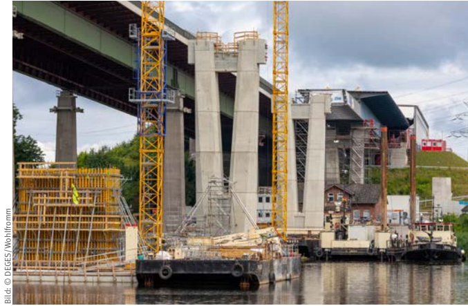
Zweiter Vershub des Stahlüberbaus bis auf Pfeiler 30
