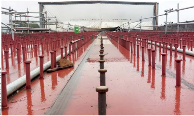
Stahlbauvorfertigung mit Kopfbolzendübeln
