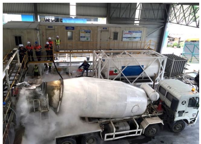
Abb. 14 Kühlung durch Lanzen mit flüssigen Stickstoff
