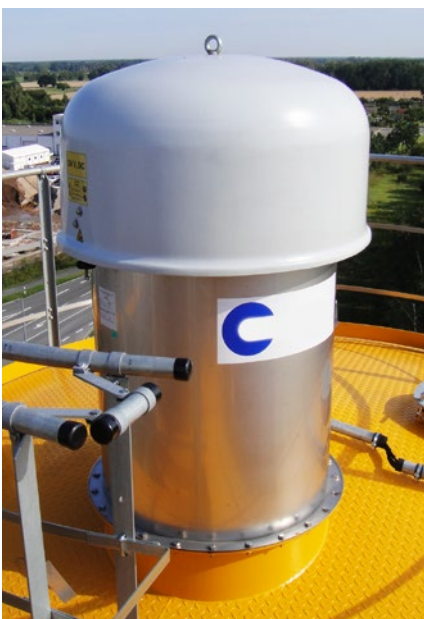
Abb. 40 Filteranlage auf einem Silo
