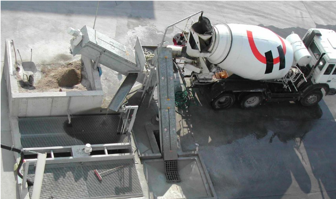
Abb. 36 Recyclinganlagen mit abgedeckten Absetzbecken
