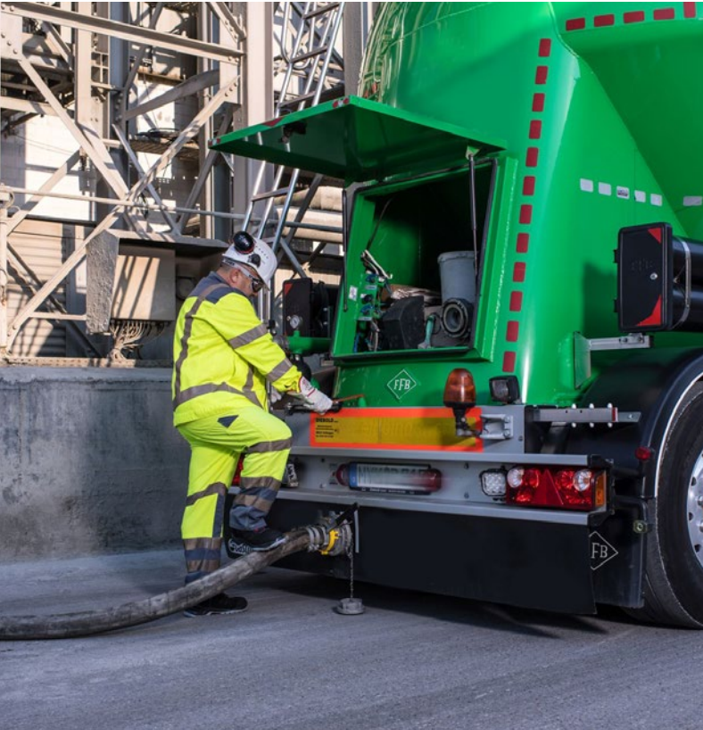
Abb. 6 Vorbereitung zur Entladung von Zement
