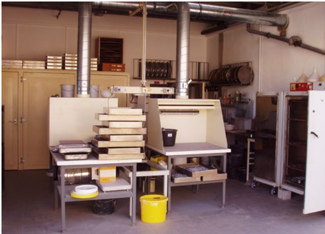
Abb. 53 Labor für Gesteinskörnungen mit Absaugung
