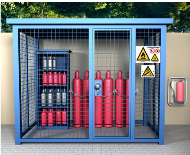
Abb. 32 Lagerung von Flüssiggasflaschen im Freien
