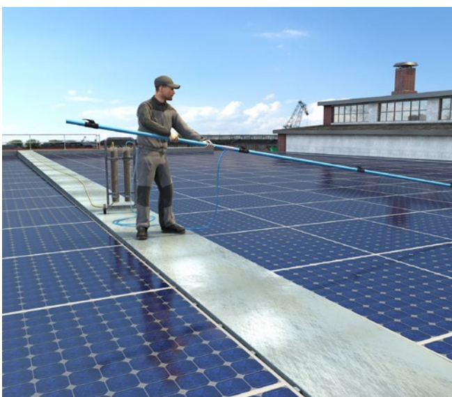
Abb. 16 Reinigung von Photovoltaikanlagen mit entmineralisiertem Wasser
