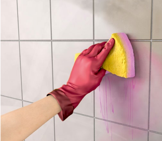
Abb. 7 Auftragen mit umgekrempelten Stulpen
