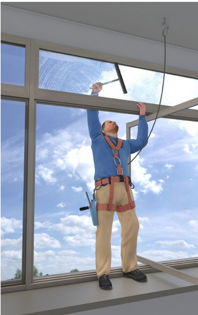
Abb. 1 Einsatz von PSAgA bei Fensterreinigung
