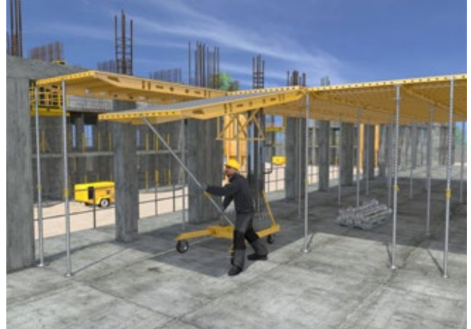
Abb. 119 Montage einer Deckenschalung mit Schalwagen von unten
