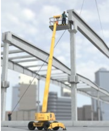
Abb. 111 Sichere Arbeitsplätze bei Montagearbeiten
