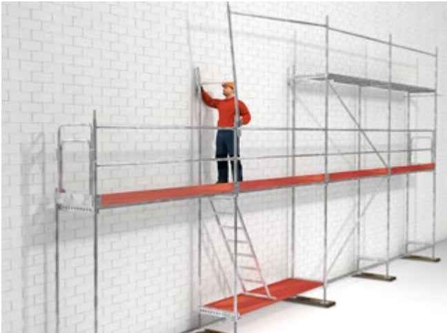
Abb. 116 Gerüstbau mit systemgebundenem Seitenschutz
