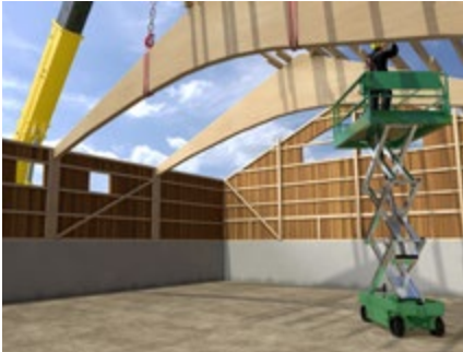
Abb. 128 Bändermontage mit Hubarbeitsbühne
