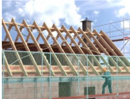
Abb. 129 Anbringen der Traufschalung
