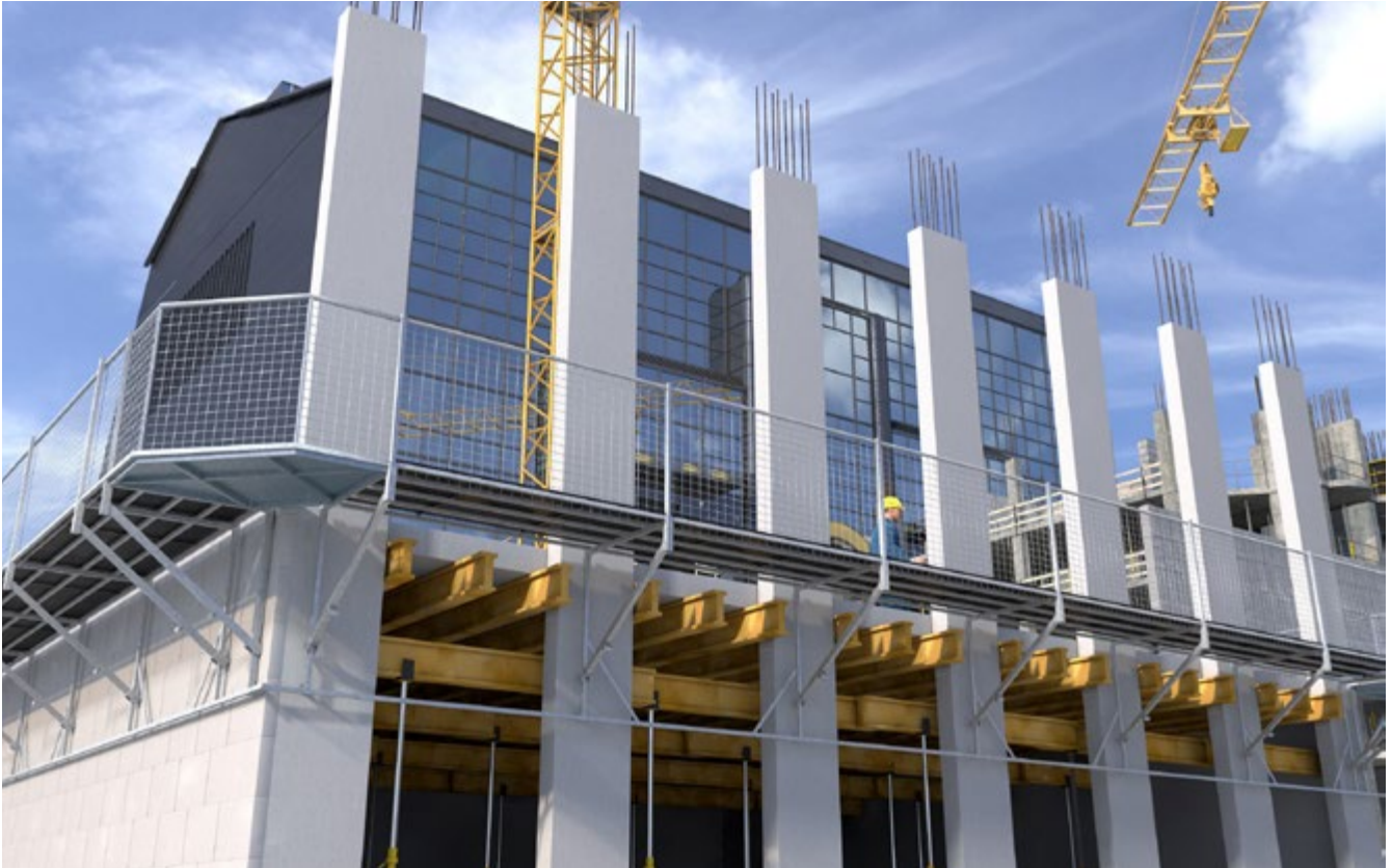
Abb. 122 Konsolgerüst an Stützen-Riegel-Konstruktion
