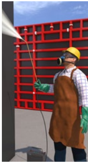
Abb.10 Sprühen von Schalöl
