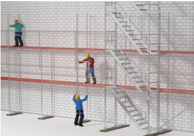
Abb. 114 Montage eines Fassadengerüsts
