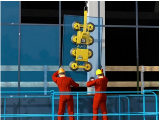
Abb. 124 Montage einer Glasfassade
