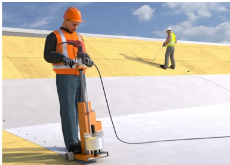
Abb. 139 Ergonomische Verlängerung von Schraubern
