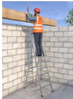
Abb. 43 Abschlagen von Lasten mithilfe einer leichten Plattformleiter
