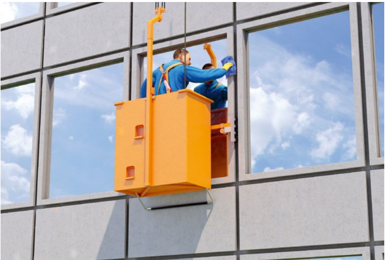
Abb. 77 Befahranlage im Einsatz
