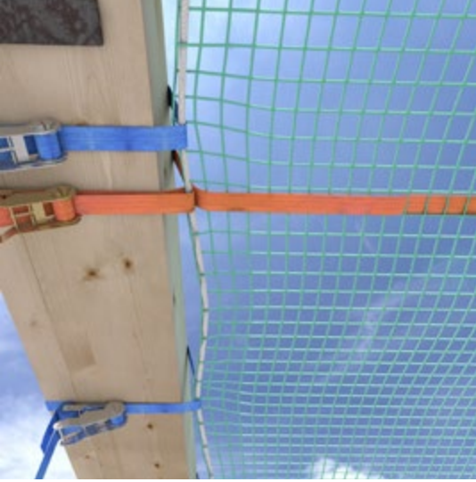
Abb. 63 Spanngurt- Randbefestigung am Holzbalken
