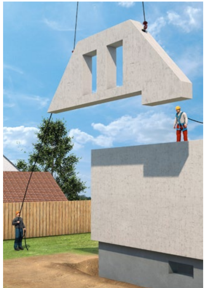
Abb. 84 Verwendung von Leitseilen beim Transport von Fertigteilen
