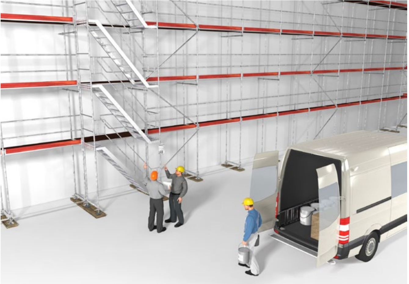
Abb. 50 Ein Gerüst ist vor der Verwendung auf offensichtliche Mängel zu überprüfen
