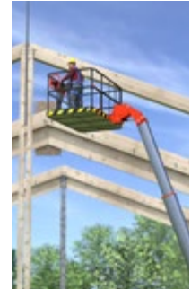
Abb. 131 Montage von Holzbauteilen
