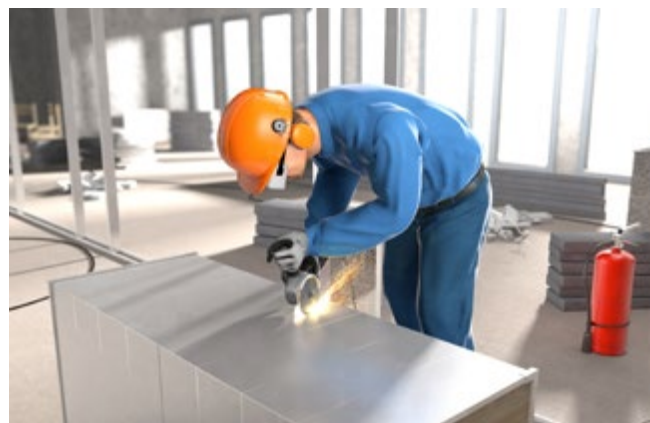
Abb. 28 Persönliche Schutzausrüstung beim Schneiden von Metall
