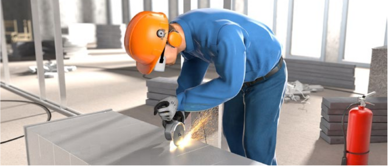
Abb. 1 Persönliche Schutzausrüstung beim Schneiden von Metall
