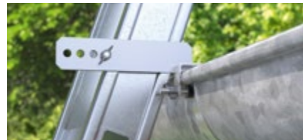
Abb. 45 Fixierung der Leiter durch Leiterhaken
