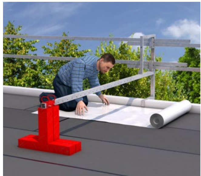
Abb. 135 Absturzsicherung bei Flachdacharbeiten
