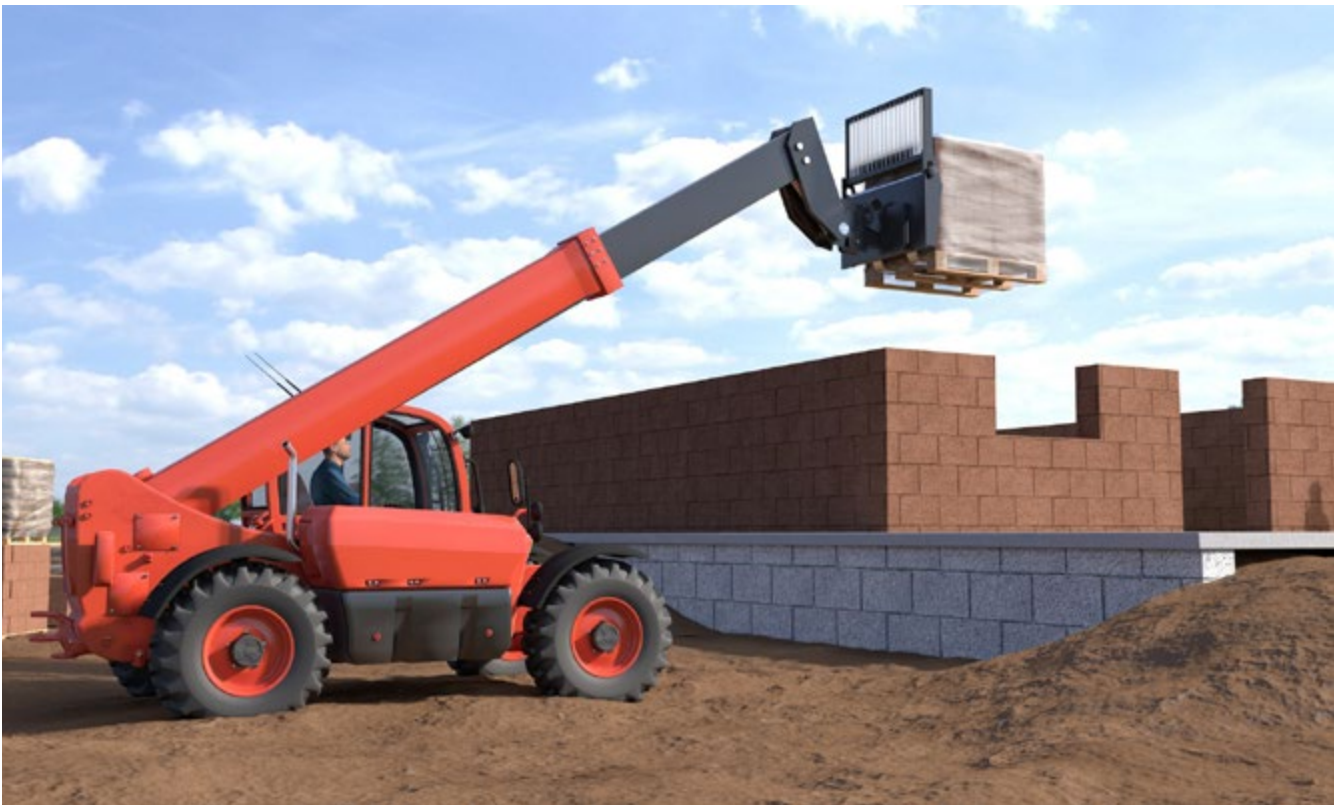
Abb. 72 Teleskopradlader beim Transport von Material
