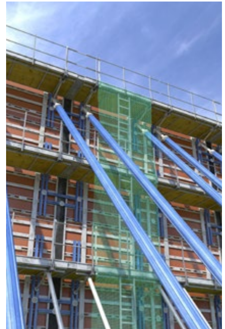
Abb. 55 Wandschalungssystem mit Seitenschutz
