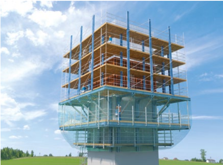
Abb. 54 Kletterschalung an turmartigem Bauwerk
