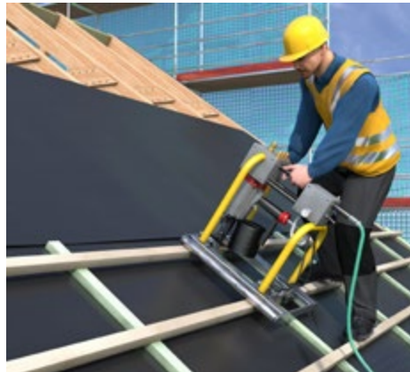
Abb. 31 Einlattergeräte unterstützen das ergonomische Arbeiten
