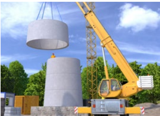
Abb. 140 Montage des Turms einer WEA
