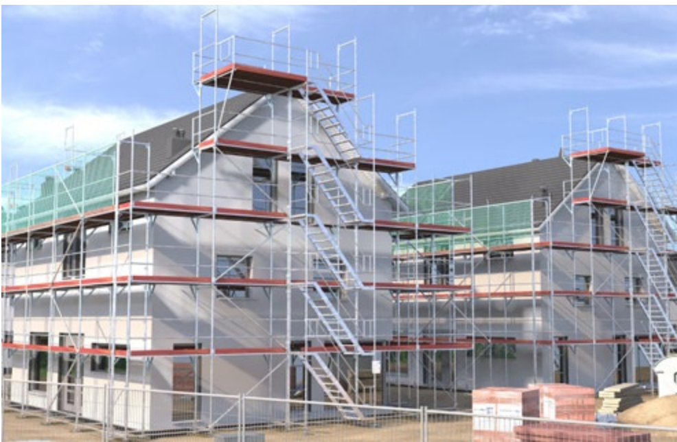
Abb. 53 Fachgerechter Zugang zum Gerüst
