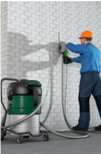
Abb. 9 Sägen mit angeschloss-nem Bau-Entstauber
