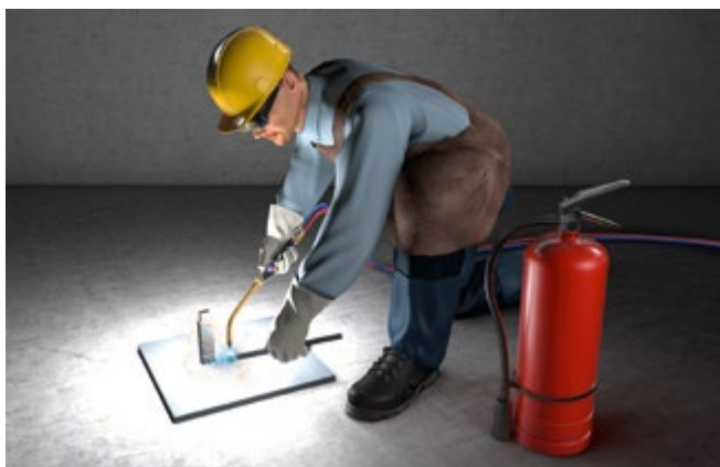
Abb. 67 Schutzausrüstung beim Gasschweißen
