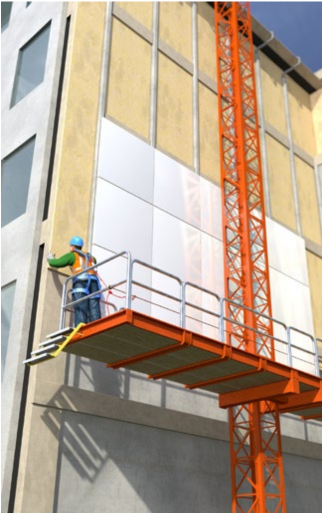
Abb. 126 Montage einer Metallfassade
