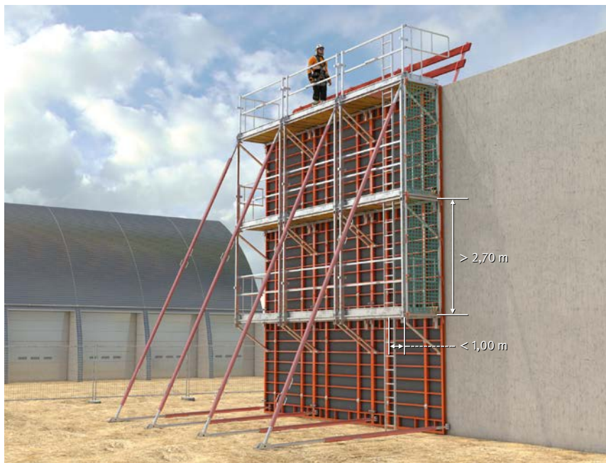
Abb. 3 Absturzsicherung und Zugang an einer Wandschalung
