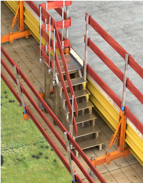
Abb. 15 Brückenkappe mit Absturzsicherungen aufgrund von er- höhter Verletzungs- gefahr beim Fall auf Gegenstände.
