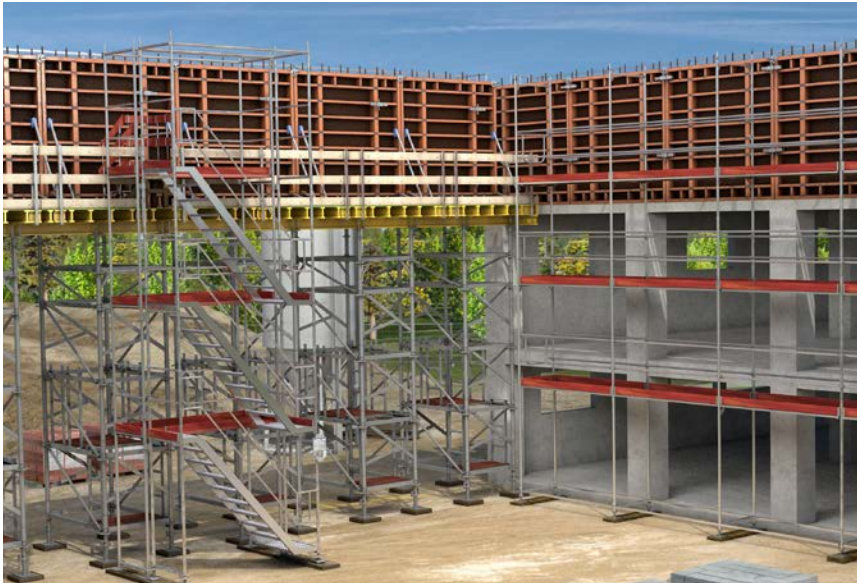
Abb. 12 Verkehrsweg an und auf Tragkonstruktion.
