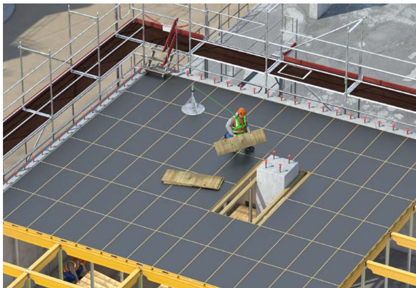
Abb. 7a Aufbau von Deckenschalungssystemen unter Verwendung von PSaG bei vorhandener Störstelle (Stützdurchbruch durch Deckenpaneele)
