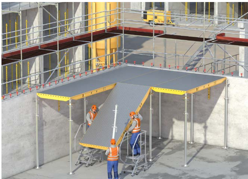
Abb. 6a Aufbau von Deckenschalungssystemen mittels Podesttreppe
