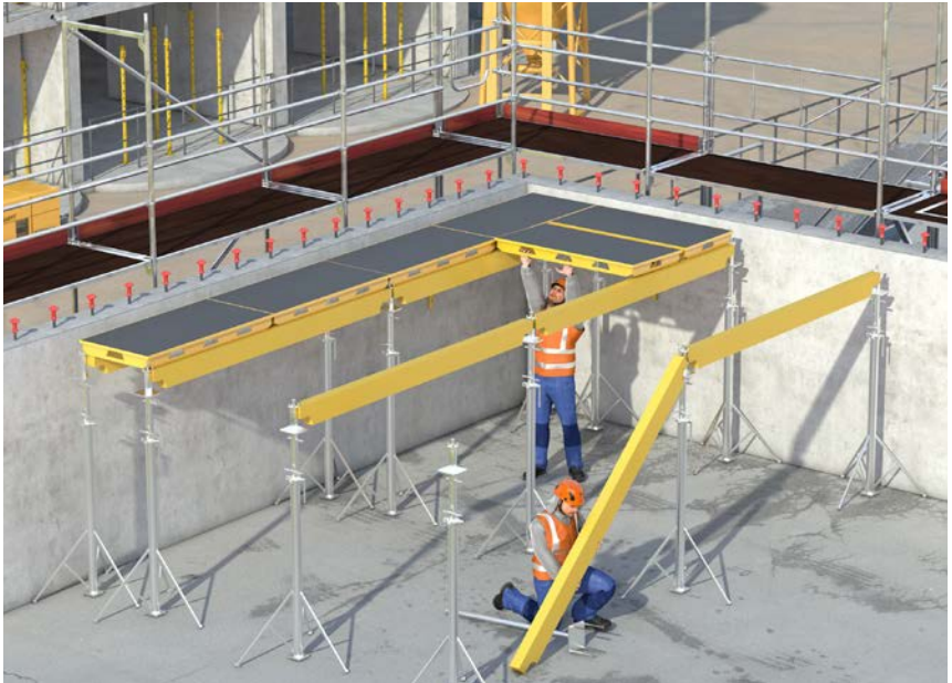
Abb. 5 Aufbau eines Deckenschalungssystems aus einer gesicherten Standposition.
