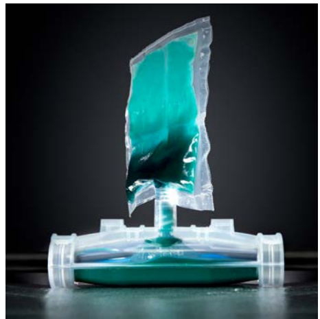
Abb. 24 Gießen der Vergussmasse in die Kabelmuffe
