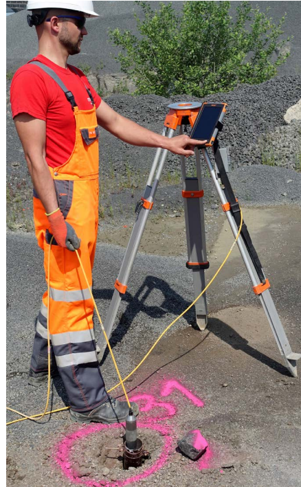
Abb. 31 Messung des Bohrlochverlaufs mit einer Bohrlochsonde
