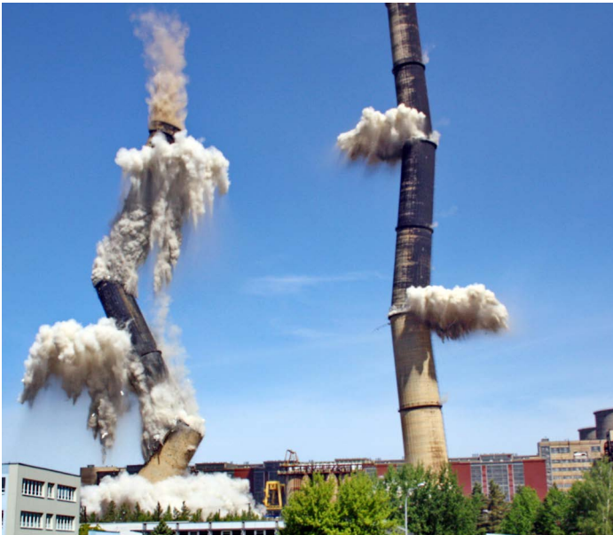
Abb. 41 Bauwerkssprengung
