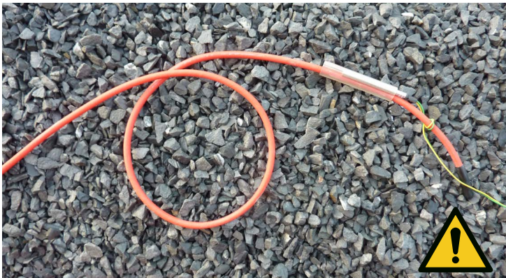
Abb. 24 Unzulässige Verlegung von Sprengschnur in einer Schlinge
