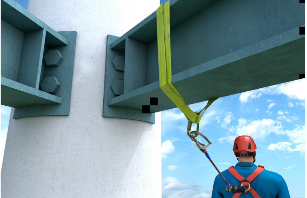
Abb. 17 Beispiel einer temporär genutzten Anschlagmöglichkeit (Stahlträger)
