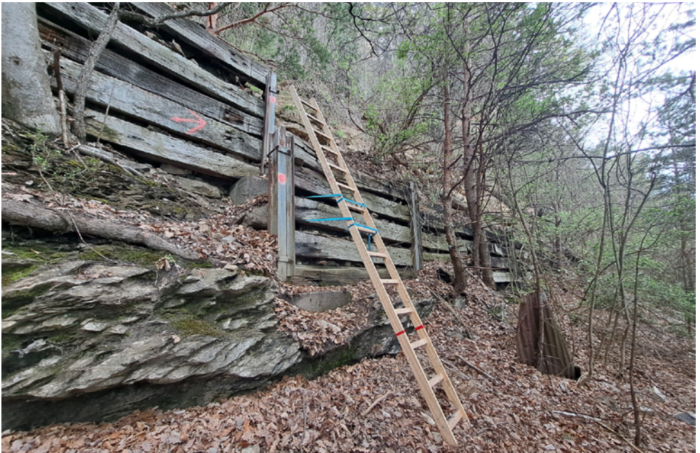
Abb. 23 Anlegeleiter als Verkehrsweg
