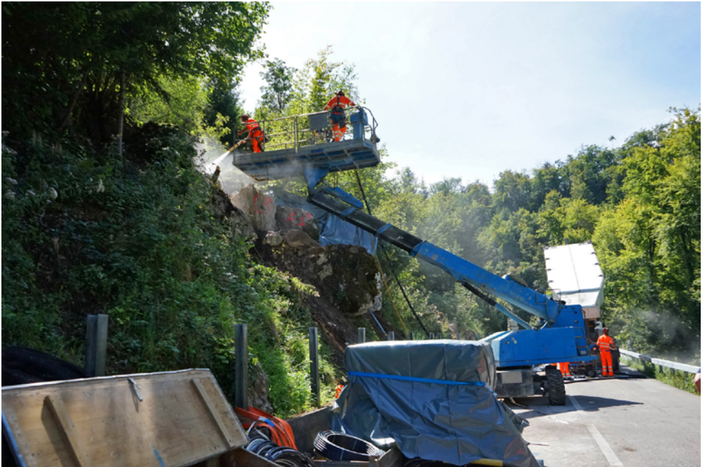
Abb. 1 Arbeiten mit einer fahrbaren Hubarbeitsbühne
