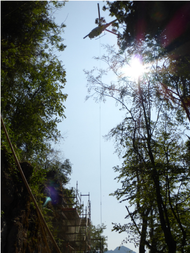
Abb. 25 Einsatz eines Helikopters für den Materialtransport
