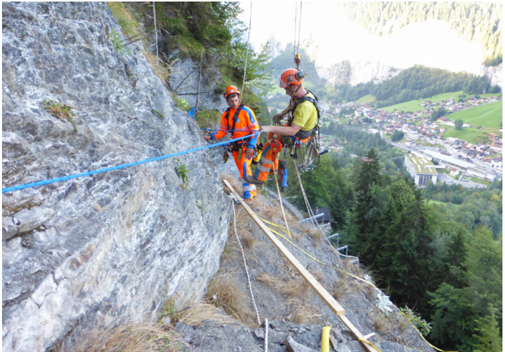
Abb. 12 Wechsel zwischen SZP und PSA gegen Absturz im gegen Absturz ungesicherten Bereich
