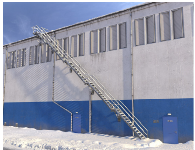
Abb. 11 Flachdachzugang über eine Außentreppe
