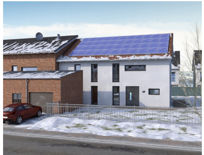
Abb. 20 Dachfläche ausgestattet mit einer Photovoltaikanlage
