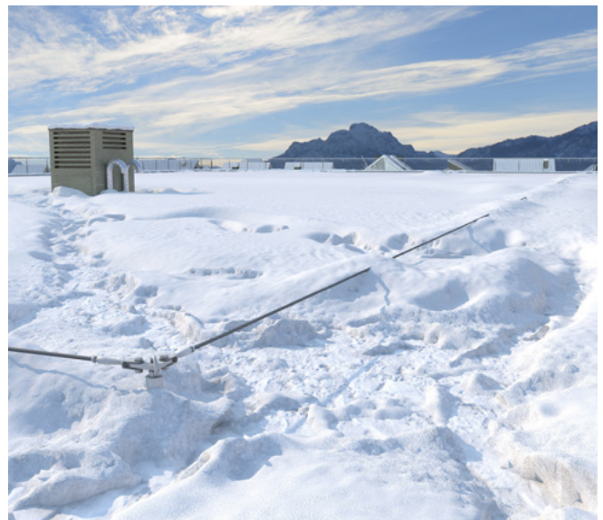
Abb. 3 Beispiel Stolpergefahr Anschlagvorrichtung
