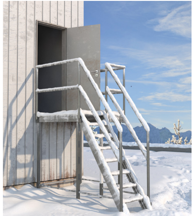
Abb. 10 Flachdachzugang von innen
