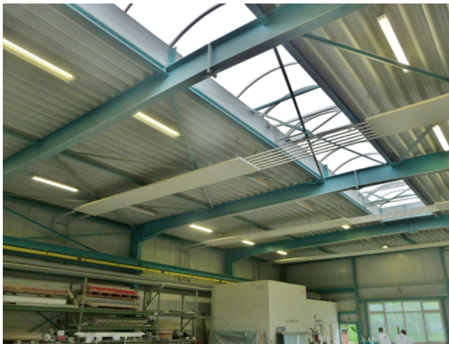
Abb. 17 Abgehängte Lichtbänder mit Tageslichtanteil
