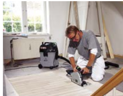
Abb. 5 Entstaubung beim Sägen
