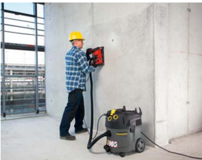
Abb. 3 Abgesaugte Mauernutfräse
