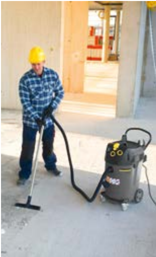
Abb. 1 Baustellenreinigung mit Staubsauger
