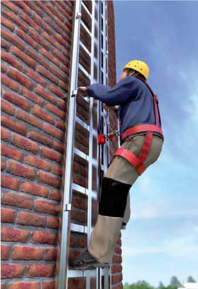
Abb. 5.17 und 5.18 Steigleiter mit Steigschutz und deren Verwendung
