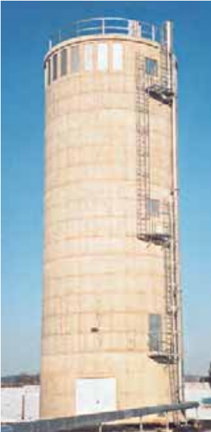
Abb. 5.12 Steigleiteraufstieg mit Wechsellpodesten
