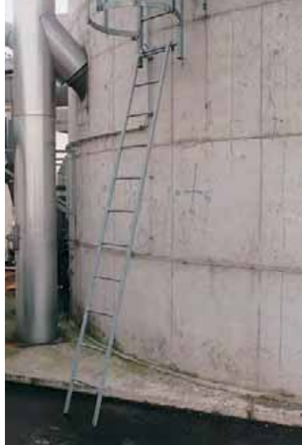
Abb. 5.13 Steigleiterzugang mit einhängbarer Anlegeleiter
