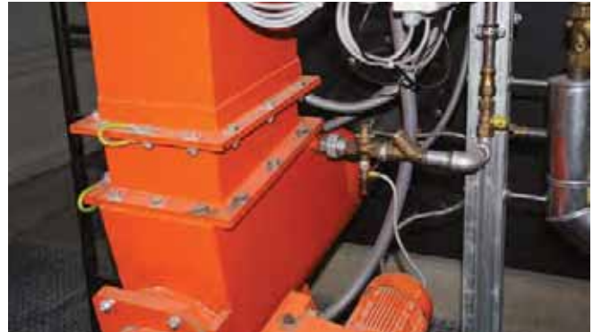
Abb. 6.23 Fallschacht von einer Siloaustragung zur Stoker-Schnecke
