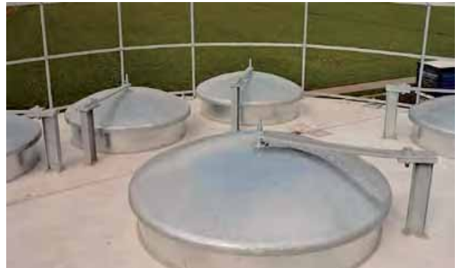
Abb. 9.9 Explosionsklappen im Deckenbereich eines Silos
