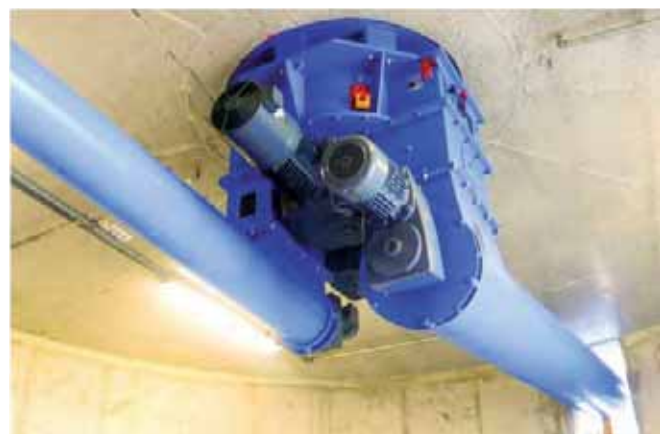
Abb. 7.12 Austrageinrichtung mit 2 gleichzeitig oder alternativ zu nutzenden Entnahmestutzen
