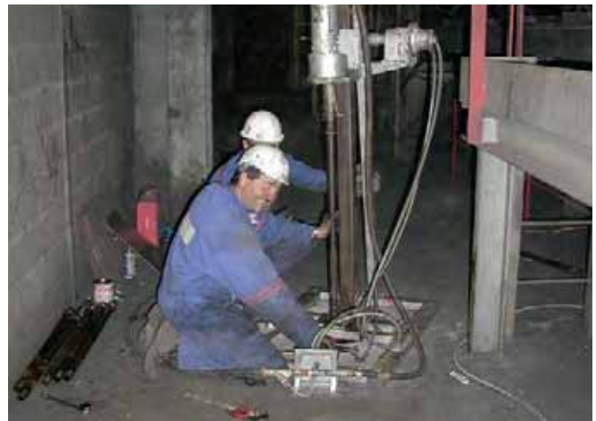
Abb. 8.3 Im Dach zum Speicherraum angesetzte Bohreinrichtung
