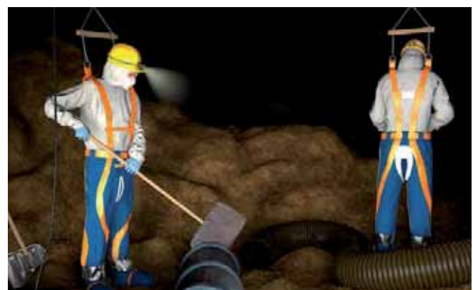
Abb. 7.17 Beispiel einer Arbeitssituation vor Ort im Silo
