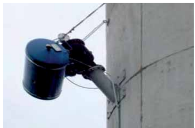
Abb. 8.2 Beispiel für eine am Silokörper montierte Druckluftkanone
