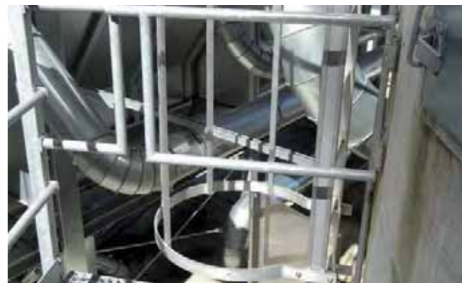
Abb. 5.10 und 5.11 Steigleiter nach ASR 1.8, Nr. 4.6
