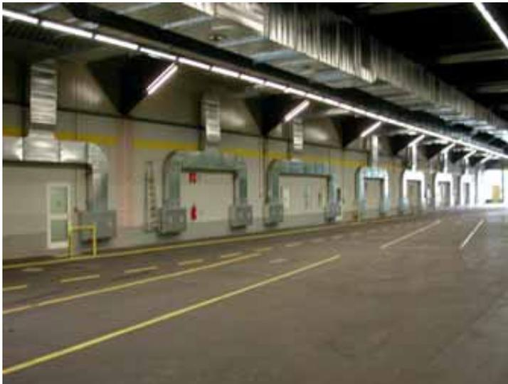
**Abbildung 42:** Bodennah angeordnete Zuluftdurchlässe neben den Verladezonen (in der obigen Skizze links angeordnet)
