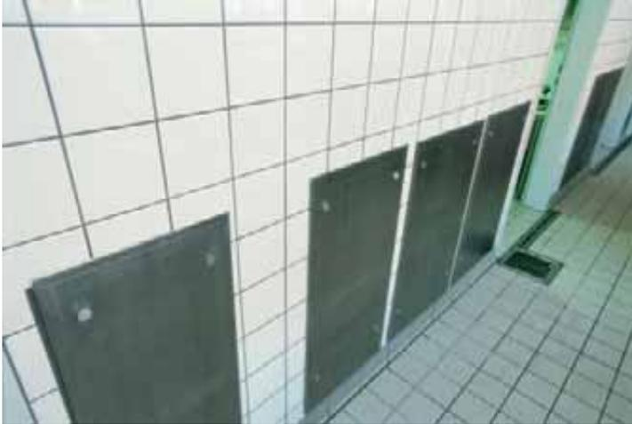
**Abbildung 28:** Bodennah positionierte Flächenluftdurchlässe aus Edelstahl, beginnend 0,2 m über Fußboden (Spritz- bzw. Reinigungsrand)
