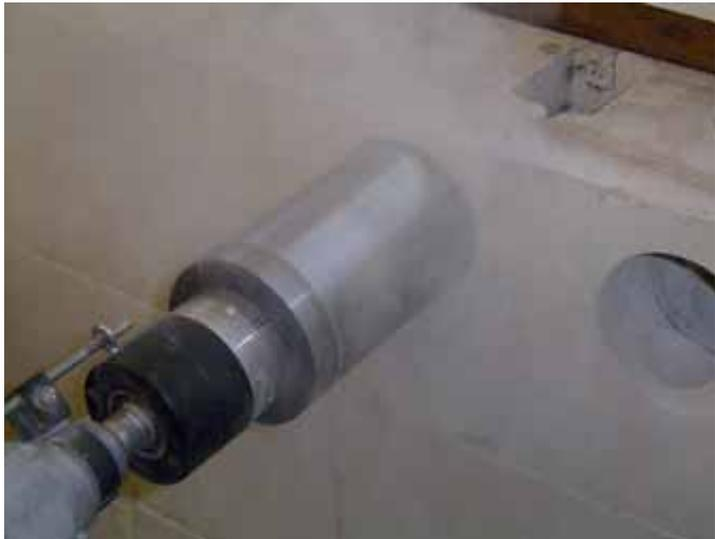
**Abbildung 34:** Kernbohrung ohne Absaugung
