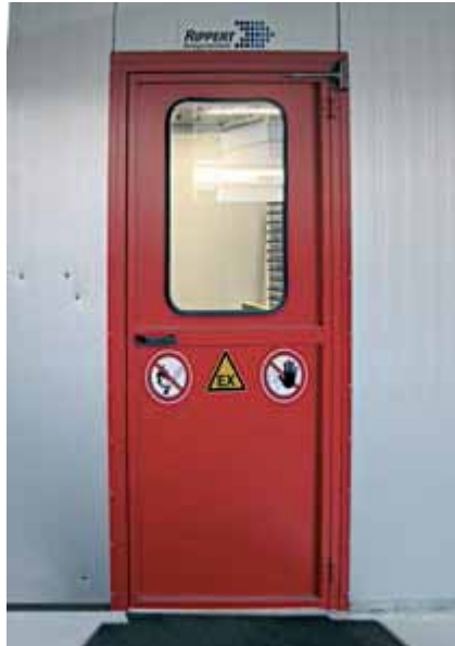
Abb. 18 Kennzeichnung an einem Zugang zum Lackiererraum
