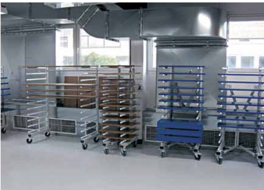
Abb. 36 Absaugung an Hordenwagen
