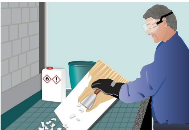
Abb. 12.4 Mitarbeiter entfernt die durch Abbeizer angelöste Farbschicht mit einem Spachtel
