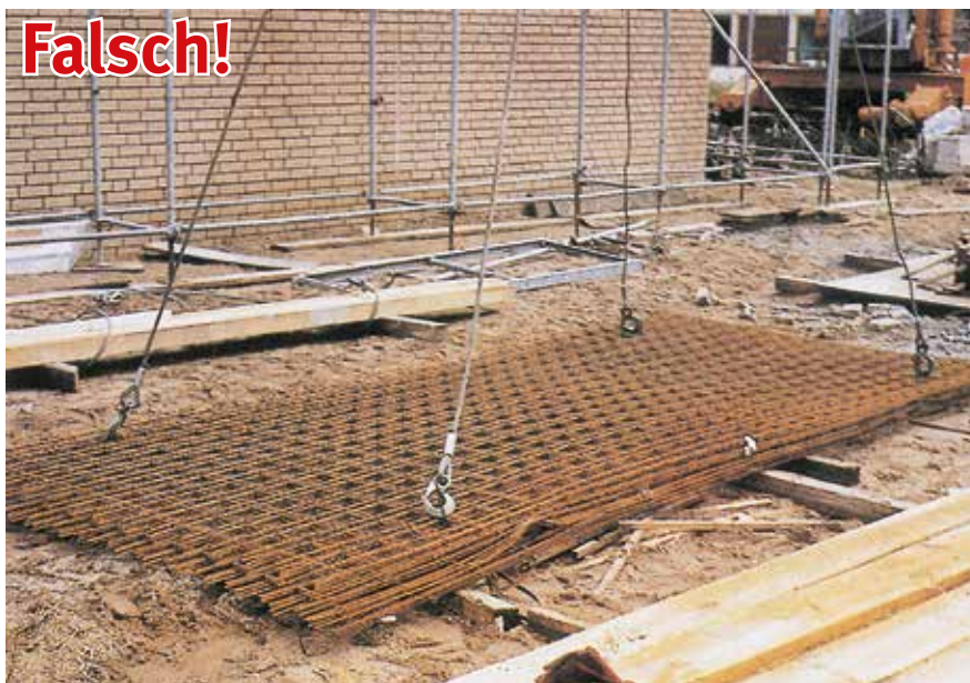
Bild 16-5: Einhängen in die Umschnürung ist lebensgefährlich!
