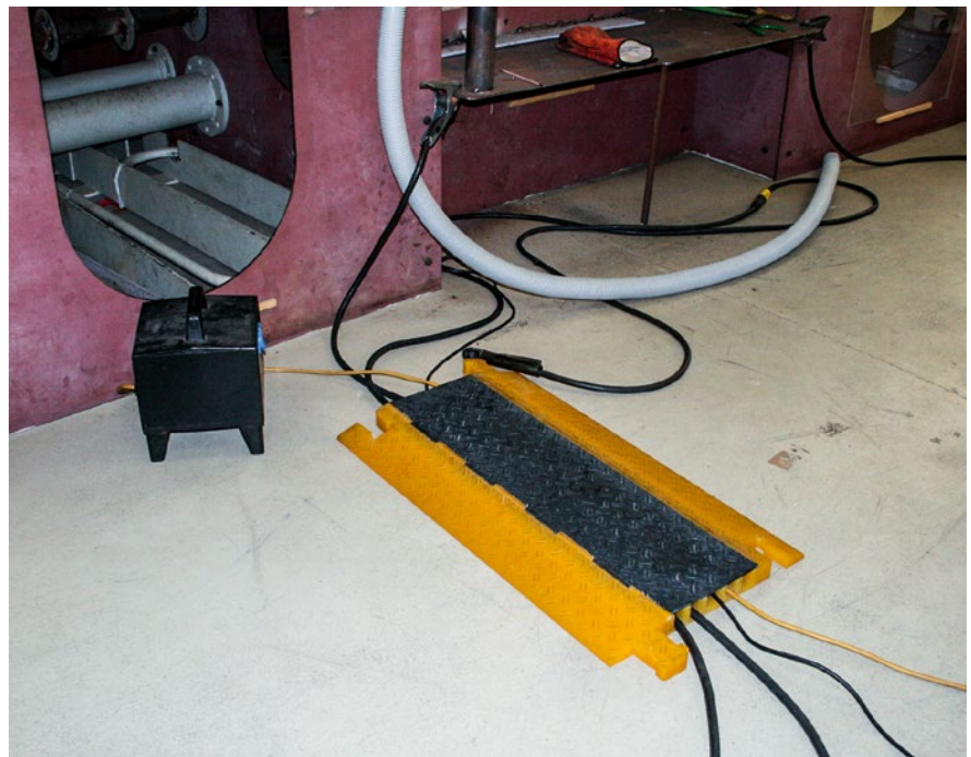
Abb. 3-4 Sicherung der Schweißleitung gegen Beschädigung beim Überfahren.
