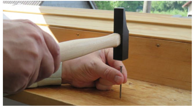
Abb. 17 Nagel oben fassen
