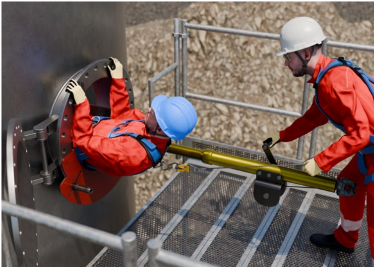
Abb. 8 Seiteneinstieg mit spezieller Halterung des Rettungshubgeräts (Quelle: DGUV Regel 113-004)
