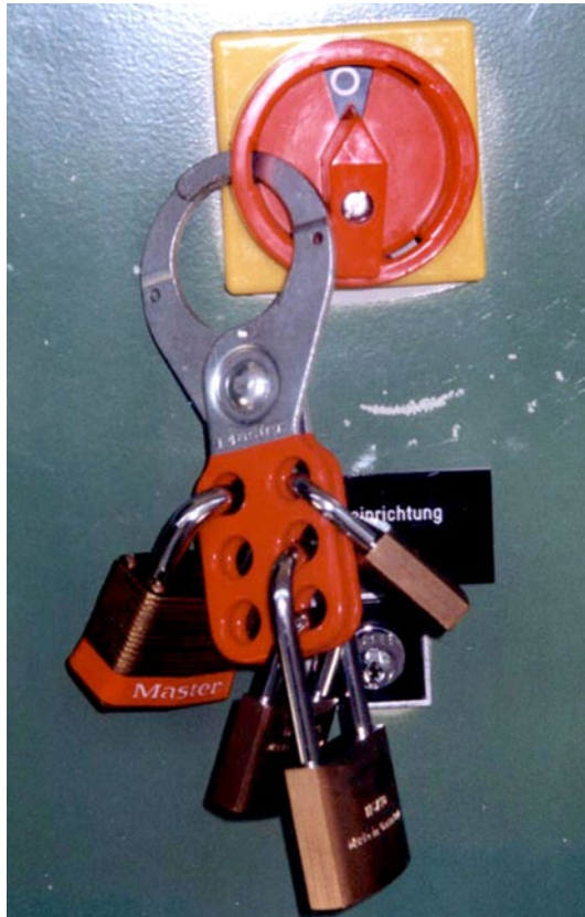
Abb. 12 Mehrfachschließbügel im Einsatz (BGHM)
