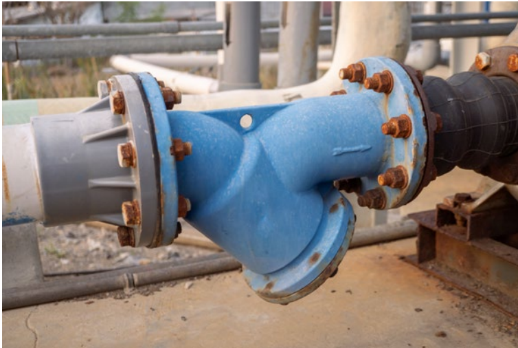
Abb. 15 Schmutzfänger zur Filterung eines Fluids (Stock Adobe)
