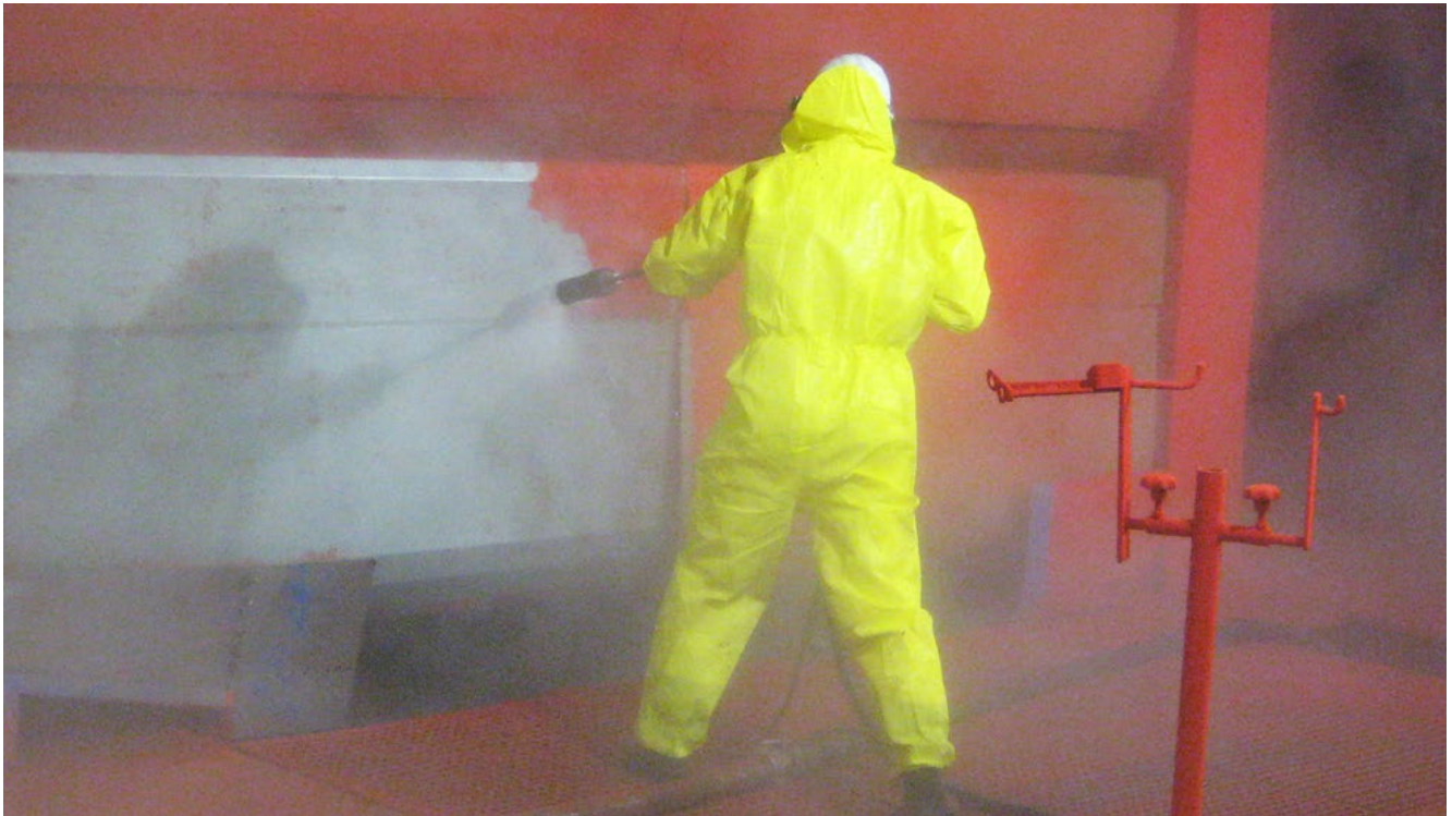
Abb. 20 Reinigung mit einem manuellen Hochdruckreiniger
