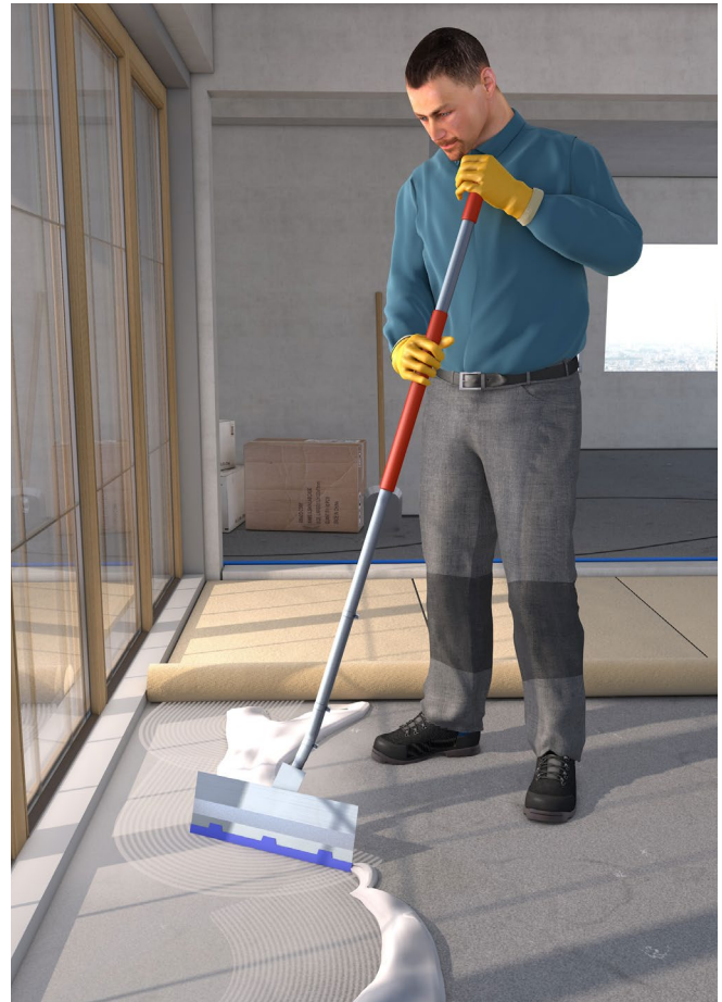
Abb. 20 Aufrechte Körperhaltung durch Einsatz eines Teleskopstiels
