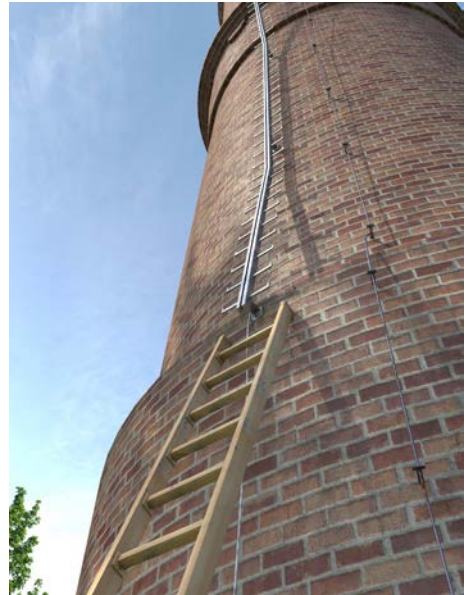
Abb. 13 Unsichere Zugangssituation bei Steigleitern an Schornsteinen
