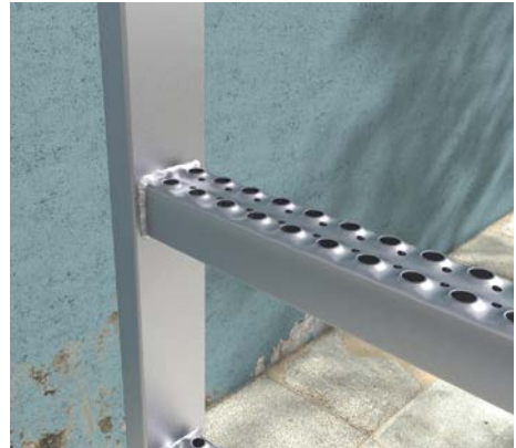
Abb. 11 Sprosse mit besonders rutschhemmender Trittfläche
