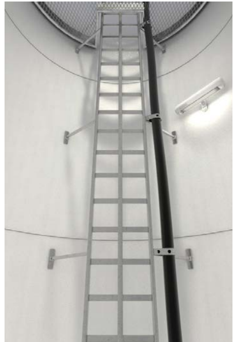
Abb. 20 Steigleiter in einer Windenergieanlage
