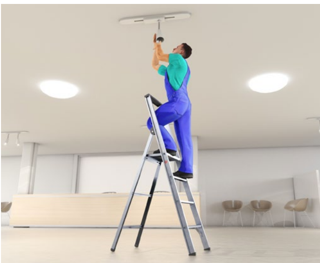
Abb. 57 Sicherer Stand auf der Stehleiter mit Plattform
