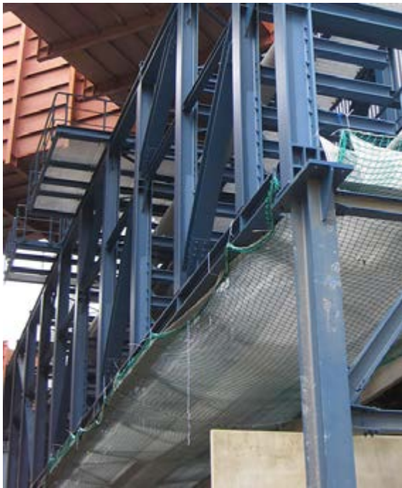
Abb. 4-9 Einsatz eines Schutznetzes zur Montage von Rosten
