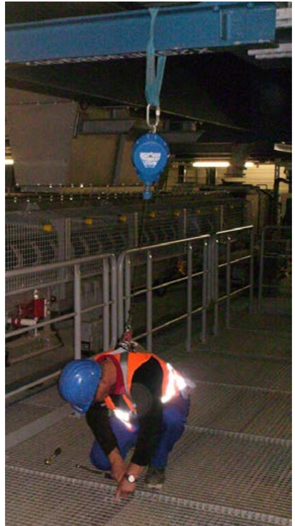
Abb. 4-16 PSA gegen Absturz mit Höhensicherungsgerät
