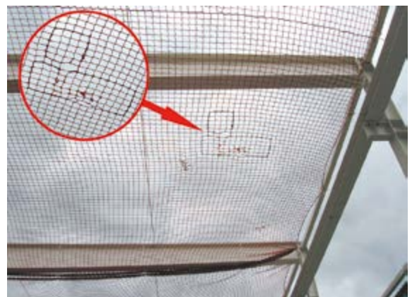
Abb. 4-14 Beschädigte Maschen; Reparatur des Netzes ist so nicht zulässig
