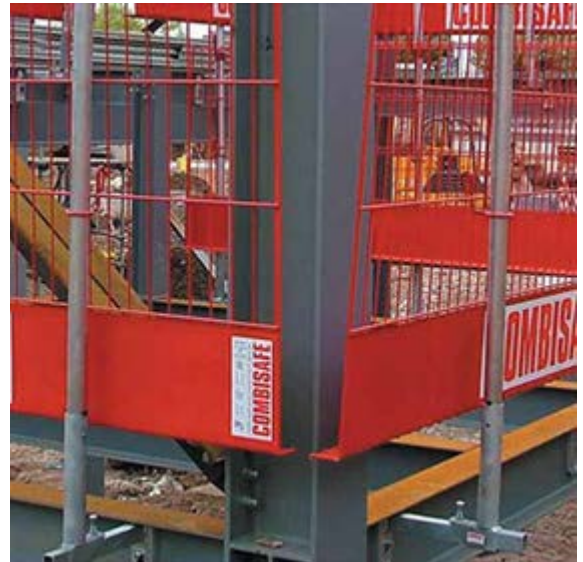
Abb. 4-3 Beispiel eines temporären Seitenschutzes
