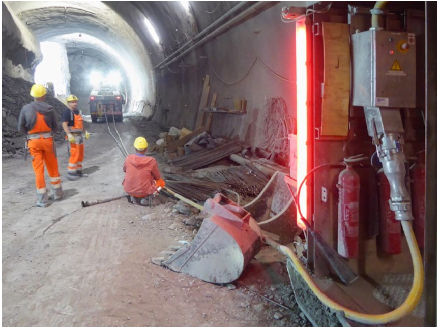
Abb. 5 Anschluss des Bohrgerätes über Steckverbindung
