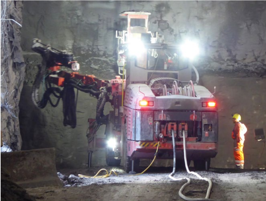
Abb. 2 Bohrgerät im Vortrieb
