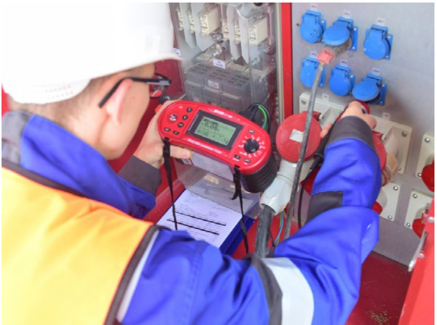
Abb. 22 Prüfung am Baustromverteiler
