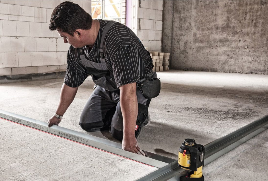
Abb. 6 Laser zum Ausrichten im Trockenbau (Klasse 2, EGW für 0,25s eingehalten)
