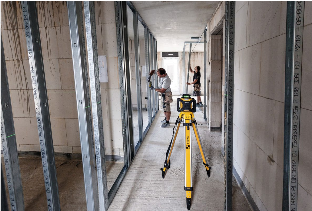
Abb. 4 Einsatz eines Rotationslasers mit Receiver (Klasse 2, EGW für 2s eingehalten)
