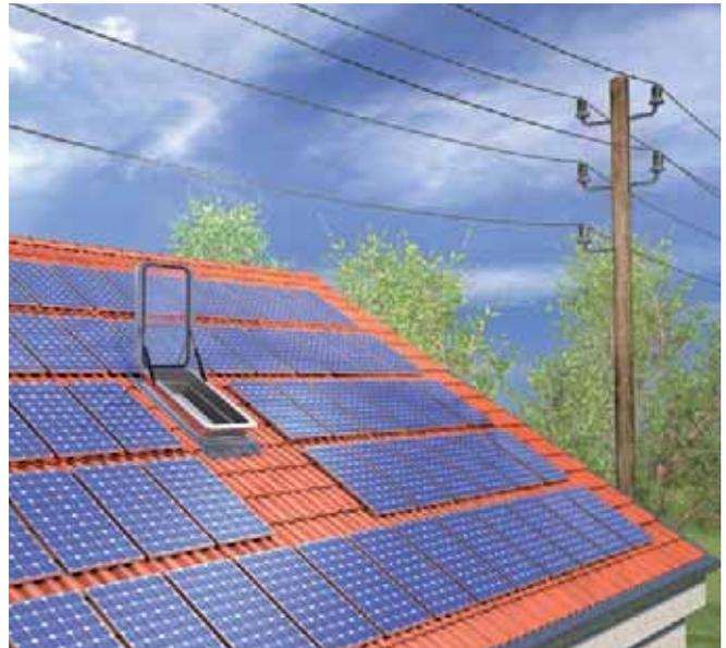
Abb. 26 Niederspannungsfreileitung in der Nähe einer PV-Anlage
