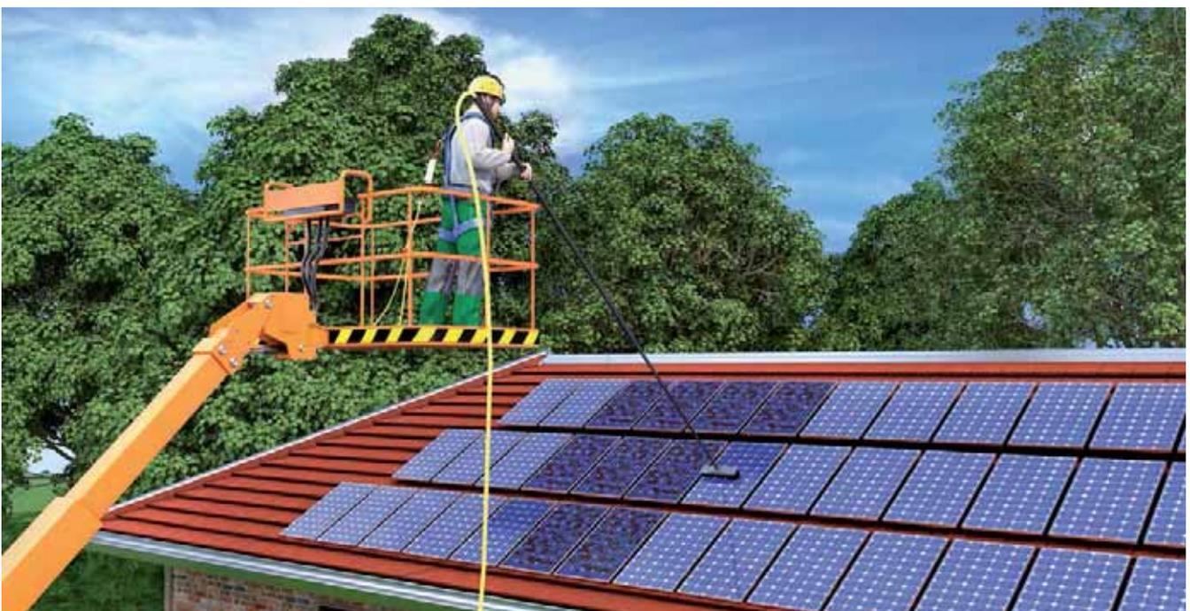
Abb. 28 Reinigung einer PV-Anlage von einer Hubarbeitsbühne aus
