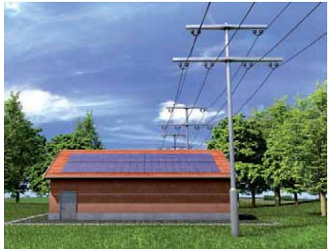
Abb. 22 PV-Anlage, für die Schutzmaßnahmen gemäß den Arbeiten in der Nähe unter Spannung stehender Teile anzuwenden sind
