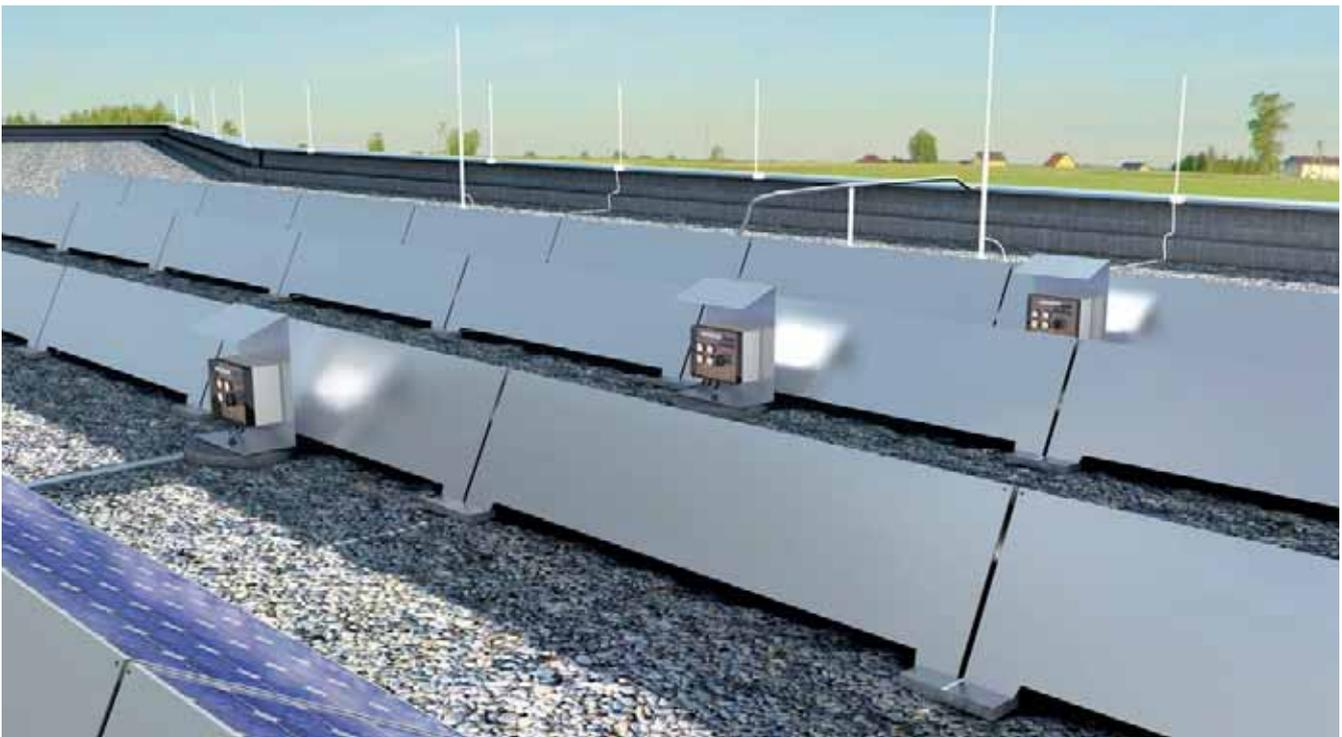
Abb. 35 Beispiel einer Blitzschutzanlage in Kombination mit einer PV-Anlage
