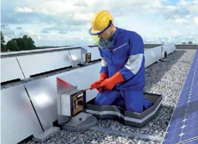
Abb. 17 Arbeiten unter Spannung mit PSA ausführen
