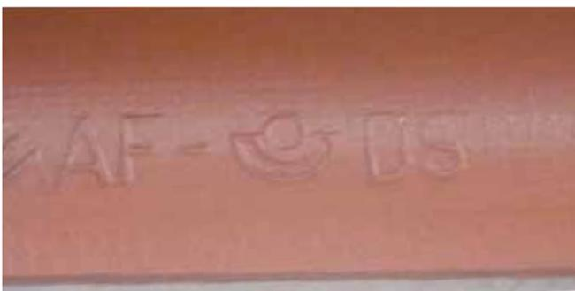
Abb. 9 Prägestempel einer Faserzementwellplatte, DS = Durchsturzsicher, AF = Asbestfrei
