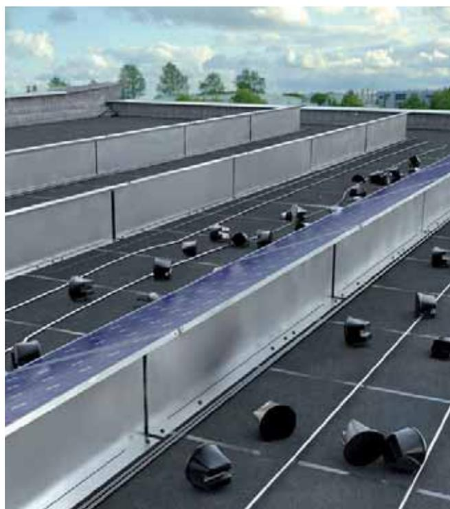
Abb. 33 Überbaute und demontierte Blitzfangeinrichtungen
