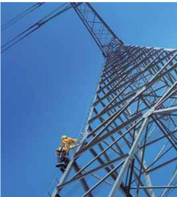
Steigschutzeinrichtungen mit fester Führung sind fest am Mast montierte Einrichtungen.
