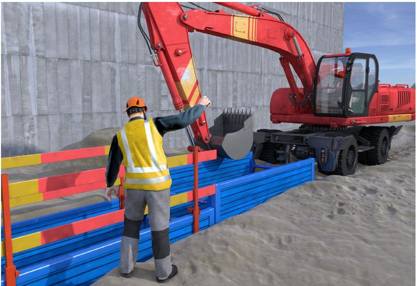
Abb. 21 Grabenverbaugeräte und Absturzsicherung
