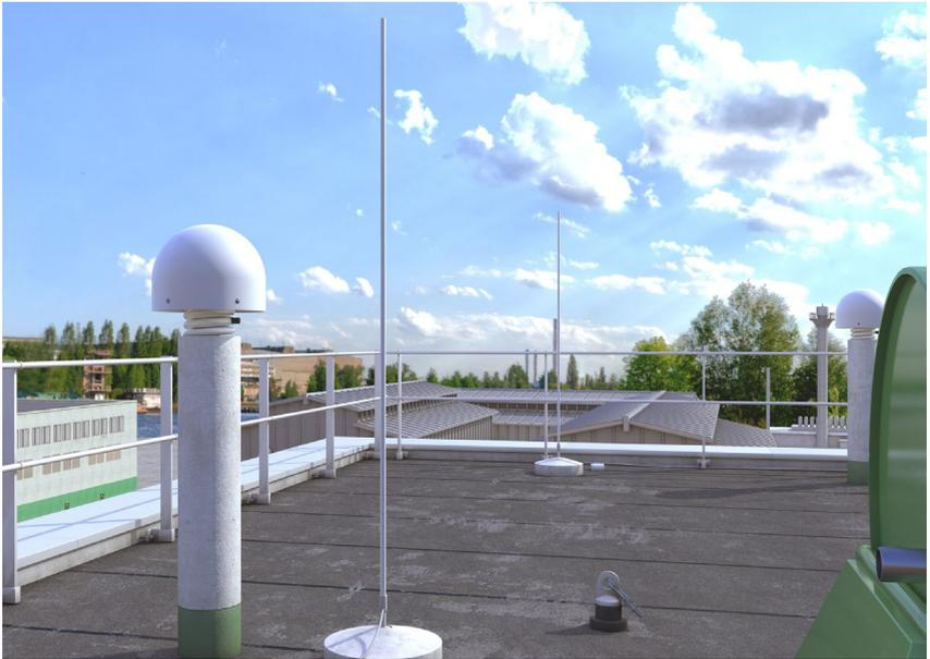
Abb. 9 Referenzstation auf einem Flachdach
