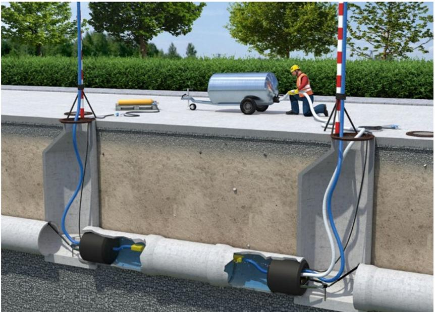
Abb. 16 Durchführung einer Wasserdruckprüfung
