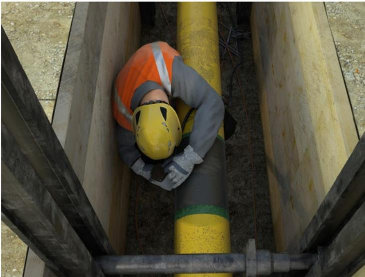
**Abb. 4** Beispiel für elektrisch leitfähige Bereiche (feuchtes Holz) mit begrenzter Bewegungsfreiheit im Rohrleitungsbaus
