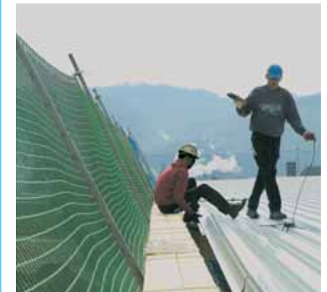
Bild 5-8: Randsicherungen mittels Schutznetzen an den Gebäudeaußenkanten, Beispiel 1 (Fa. Huck)
