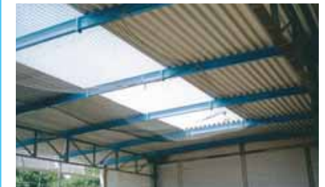
Bild 5-21: Einsatz von Schutznetzen bei der Errichtung von Bauwerken unter 5 m Firsthöhe (z. B. Discountermärkte oder kleine Stahlbauhallen)
