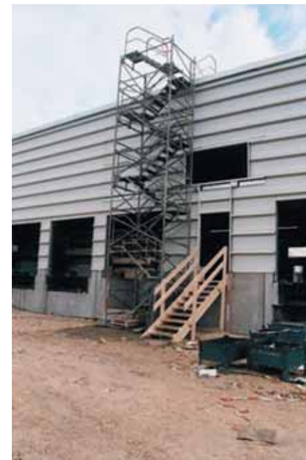
Bild 5-2: Bautreppe und Treppenturm als Zugang
