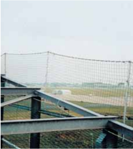
Bild 5-9: Randsicherungen mittels Schutznetzen an den Gebäudeaußenkanten, Beispiel 2
