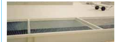
Bild 5-28 Absturz-sicherung für Lichtkuppeln (Fa. Kee Klamp)
