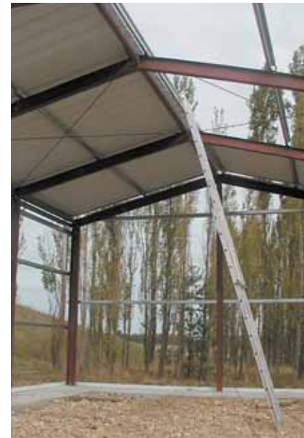
Bild 1: Halle mit einer Firsthöhe bis 5 m – hier ohne Ausnetzung!
