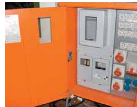
Bild 4-1: Baustromverteiler
