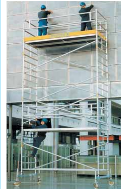
Bild 5-33: Fahrbare Arbeitsbühne entsprechend Aufbau- und Verwendungsanleitung
