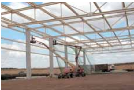
Bild 5-22: Aufhängung der Netze mit Hubarbeitsbühnen
