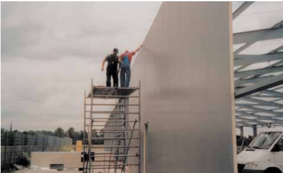
Bild 5-34: Wandmontage mit einer unvorschriftsmäßig aufgebauten Arbeitsbühne
