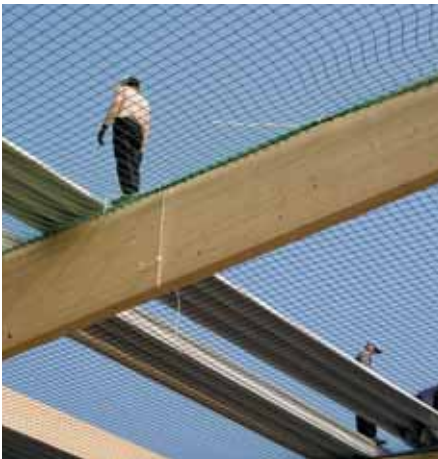
Bild 5-16: Schutznetz als Auffangnetz an der Verlegekante (Fa. Huck)
