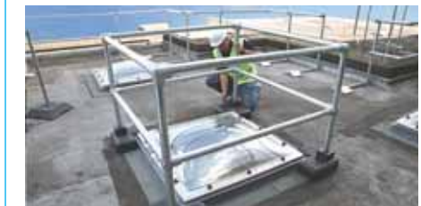
Bild 5-28 Absturz-sicherung für Lichtkuppeln (Fa. Kee Klamp)
