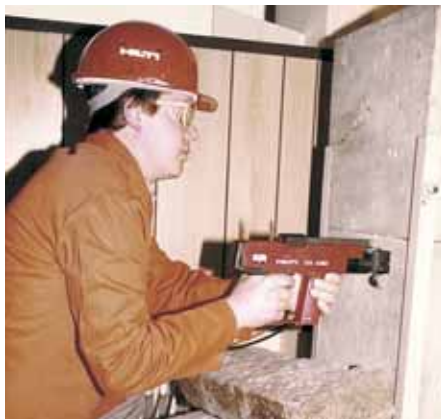
Bild 4-4: Bolzenschubwerkzeug (Fa. Hilti)
