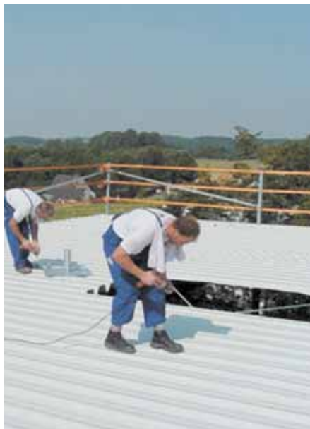
Bild 5-12: Dreiteiliger Seitenschutz mittels Spanngurten – temporäres Geländer System Goldbeck
