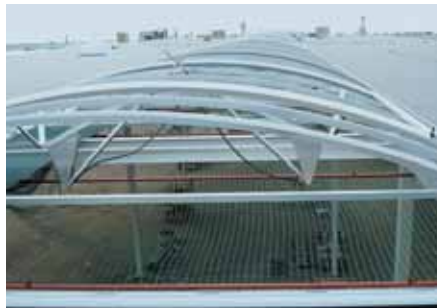
Bild 5-18: Schutznetze unter einem Lichtband
