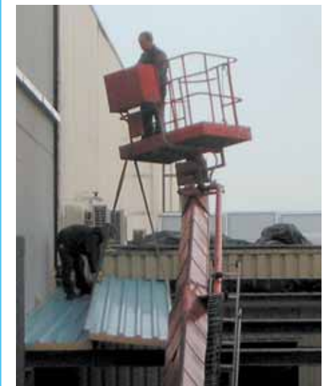
Bild 5-36: Überlastete Hubarbeitsbühne bei der Wandmontage
