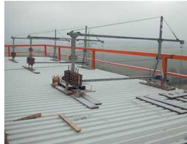
Bild 5-39: Gerüst zur Wandmontage
