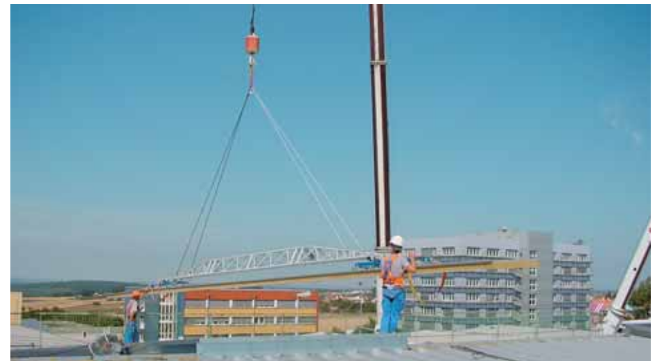
Bild 6-1: Vakuumheber im Einsatz
