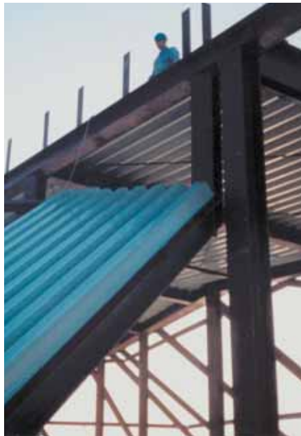
Bild 5-6: Notwendigkeit von Sicherungsmaßnahmen an den Dachaußenkanten
