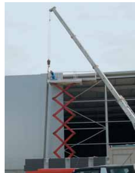
Bild 5-35: Scherenhubarbeitsbühne bei der Wandmontage
