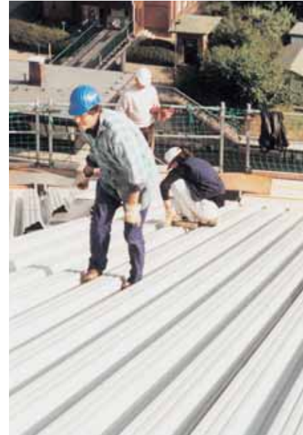
Bild 5-13: Dachfanggerüst (Dachneigungen von 20° bis 60°) als Absturzsicherung an der Traufkante
