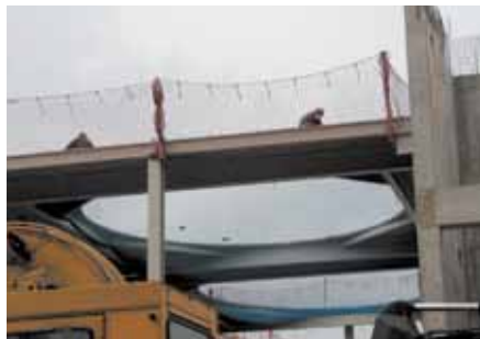
Bild 5-19: Schutznetze im Randbereich und als Auffangnetz an der Montagestelle
