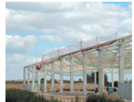
Bild 5-15: Montage der Randsicherung mittels Hubarbeitsbühne
