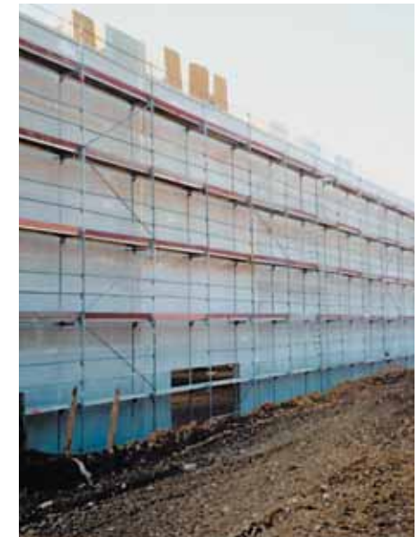
Bild 5-39: Gerüst zur Wandmontage
