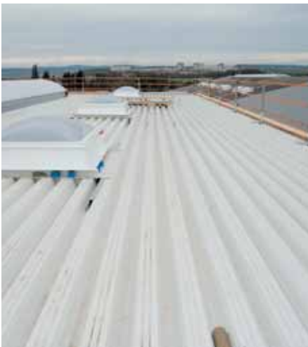
Bild 5-10: Dreiteiliger Seitenschutz als Absturzsicherung
