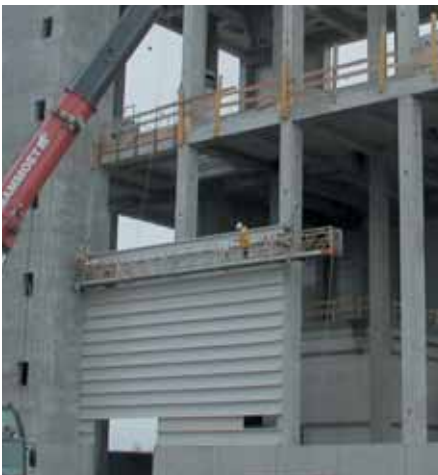
Bild 5-37 Wandmontage mit Arbeitsbühne
