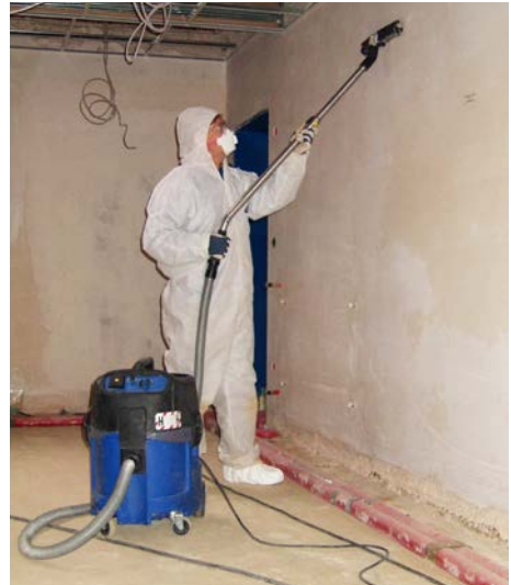
Abb. 7 Feinreinigung des Sanierungsbereiches
